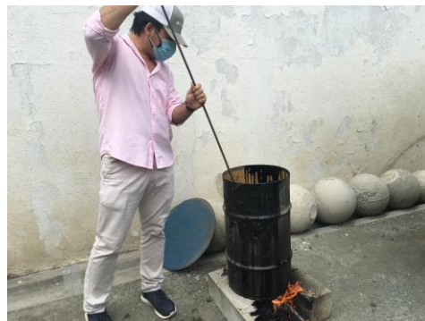
Figura 57. Removiendo el asfalto caliente
