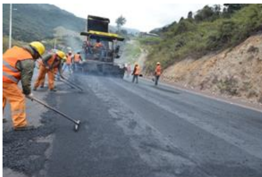
Figura 4. Colocación de mezcla asfáltica modificada en la vía Pifo-Papallacta
