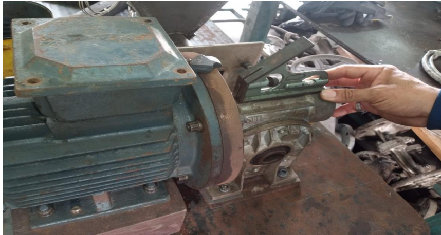
Figura 66: Instalación del motor con reductor de velocidad. Fuente: Chalaco & Muñoz (2021)
