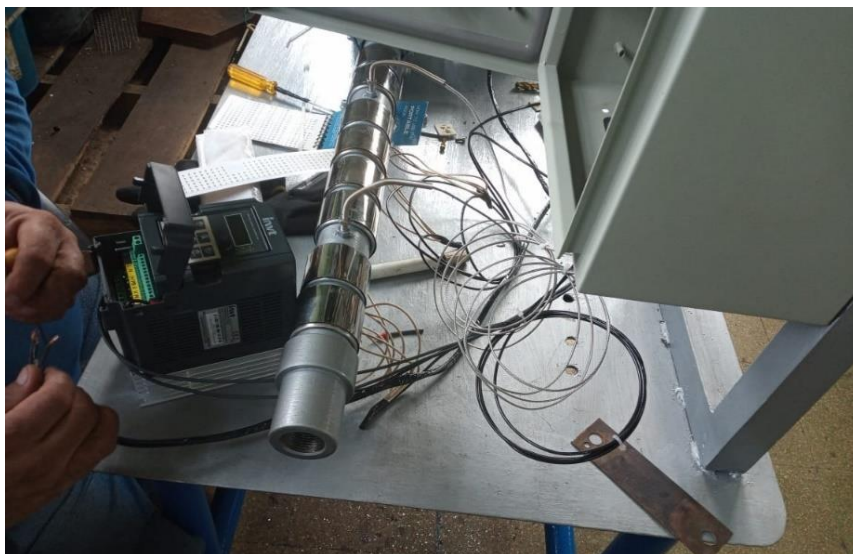
Figura 68: Instalación de conexiones electrónicas del variador de frecuencias. Fuente: Chalaco & Muñoz (2021)
