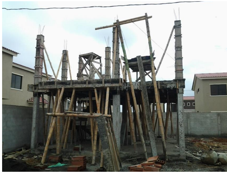
Figura 16. Construcción de obra
