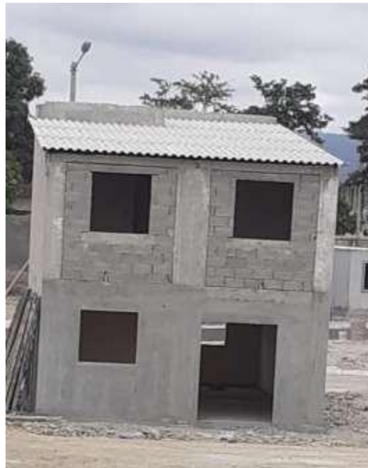
Figura 17. Registro fotográfico rubro Cubierta concluido. Elaborado por: Garcés (2021)
