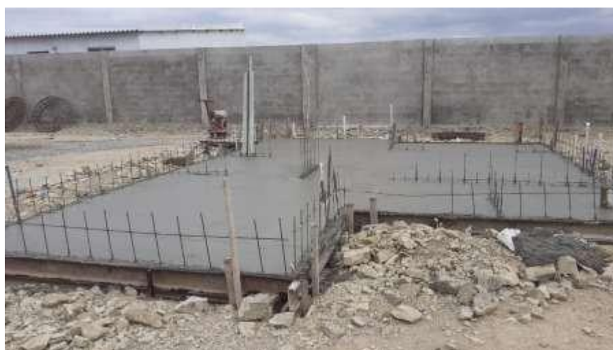
Figura 13. Registro fotográfico rubro Cimentación concluido. Elaborado por: Garcés (2021)
