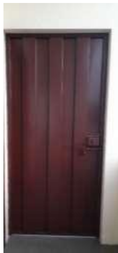
Figura 22. Registro fotográfico rubro Cerrajería concluido. Elaborado por: Garcés (2021)
