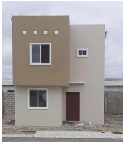
Figura 23. Registro fotográfico rubro Pinturas concluido. Elaborado por: Garcés (2021)
