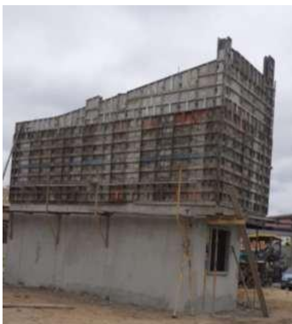
Figura 15. Registro fotográfico rubro Muros Planta Alta concluido. Elaborado por: Garcés (2021)
