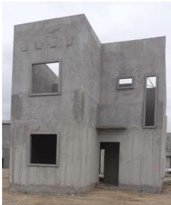
Figura 18. Registro fotográfico rubro Albañilería en proceso de resanes. Elaborado por: Garcés (2021)
