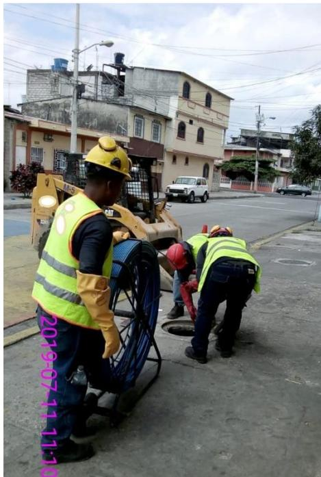
**Verificación de equipos:** Antes del inicio de cualquier actividad el área de mantenimiento realizara el respectivo control de cada uno de los equipos que van a intervenir en la actividad de Pipe Bursting los cuales se detallan a continuación:
