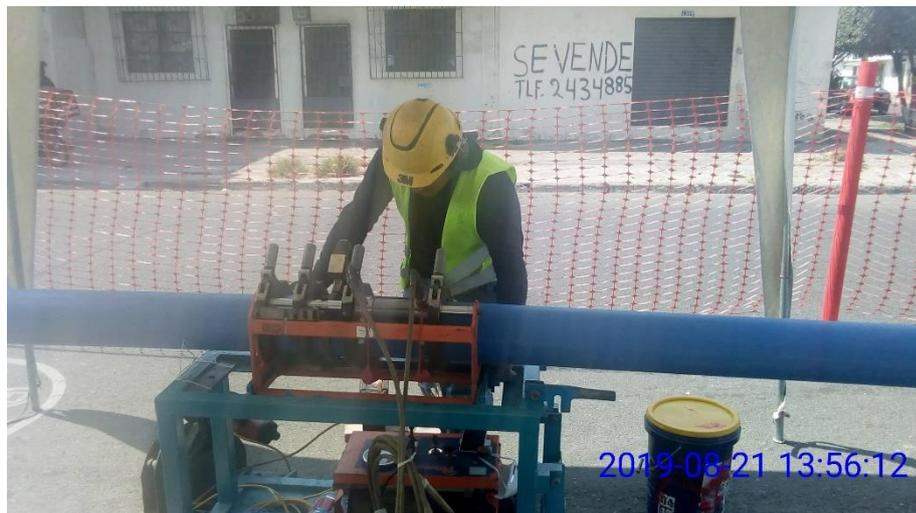
**Rehabilitación de tubería existente:** Ingresadas las barras hasta el otro extremo y soldada la tubería por electrofusión, se procede a colocar en la barra el cabezal de expansión incluida la tubería de PEAD; realizado lo indicado anteriormente se procede mediante del
