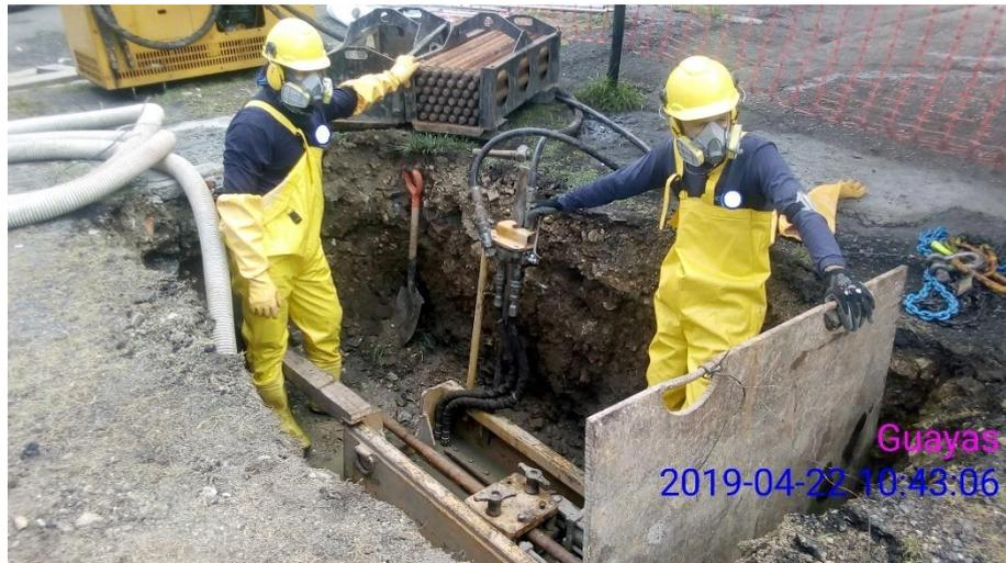
**Soldadura de tubería de Pead:** Como actividad alterna se realiza la soldadura de la tubería de PEAD (polietileno de alta densidad) del diámetro correspondiente previo a estudio realizado, mediante equipo de termofusión y personal calificado.
