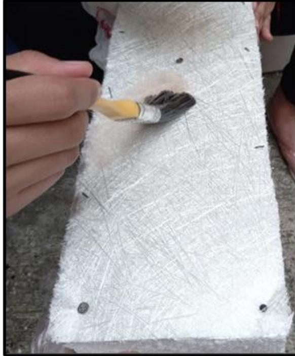
**Figura 45. Barrido de resina con secante en la fibra de vidrio**
