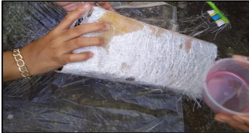
**Figura 26. Colocación de resina y secante a la fibra de vidrio**
