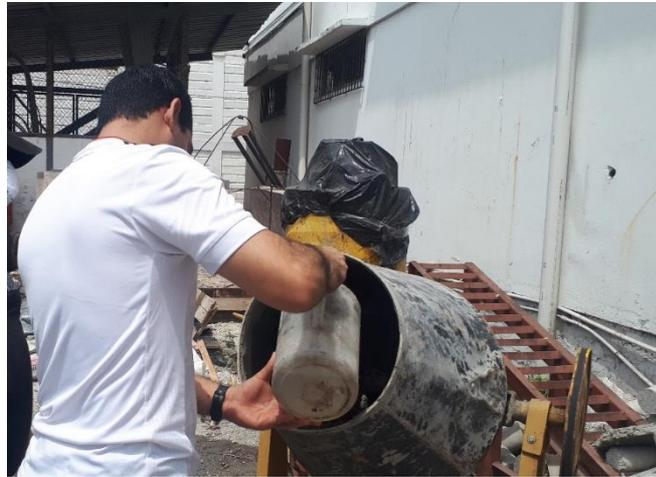
**Ilustración 10** Adicionar la cantidad de agua según dosificación.
