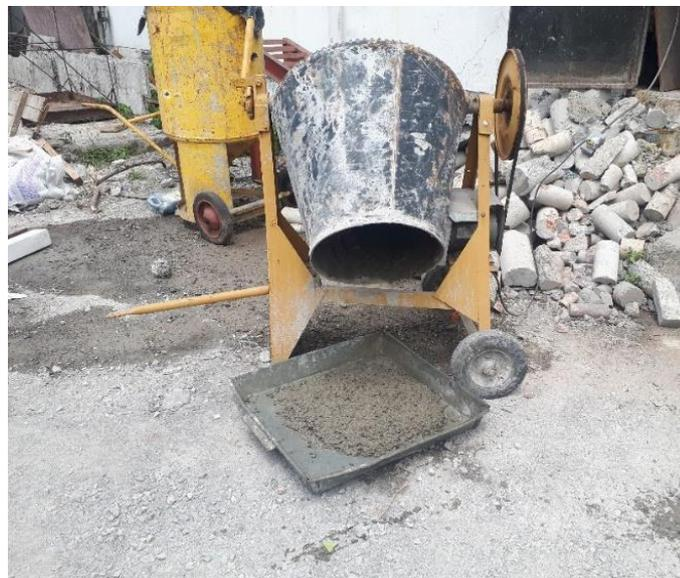
**Ilustración 11** Mezcla realizada para poder llenar los cilindros.
