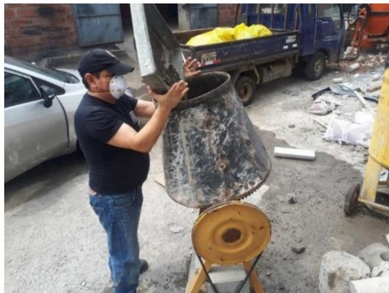
**Ilustración 7** Colocación del material granular en la mezcladora de concreto.
