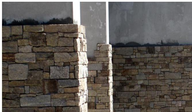
**Ilustración 1** Fachaleta Natural usada en exteriores como recubrimiento debido a su durabilidad para proteger fachadas.
