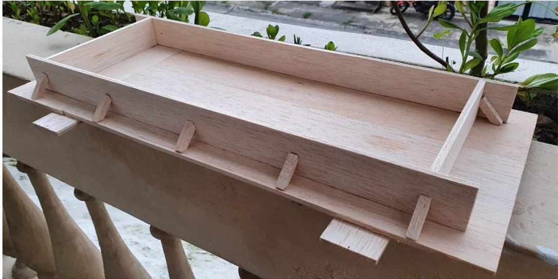
**Ilustración 28** Encofrado base que tiene soportes para cuando el mortero realice el correspondiente fraguado de 40 x 15 x 2 cms.
