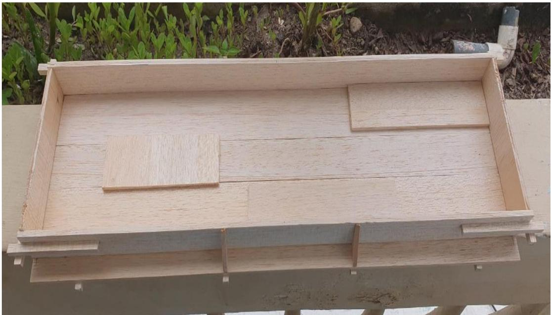
**Ilustración 33** Encofrado base para una fachaleta de 60 cm de base x 15 cm de altura y 2 cm de espesor
