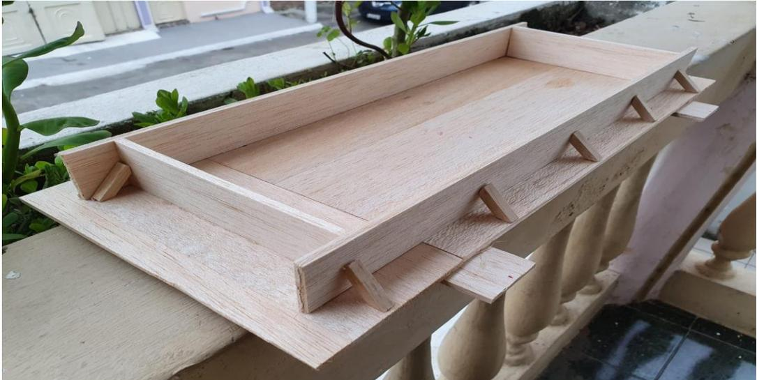
**Ilustración 26** Encofrado base de madera para verte la mezcla de mortero con poliestireno expandido de 40 x 15 x 2 cms
