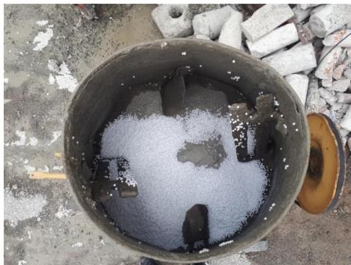
**Ilustración 13** Agregando EPS a la mezcla dosificada.
