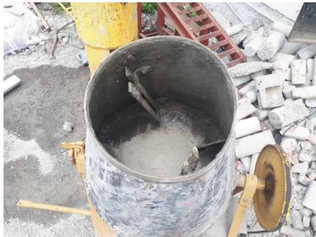
**Ilustración 9** Colocación de los materiales en la mezcladora de concreto.
