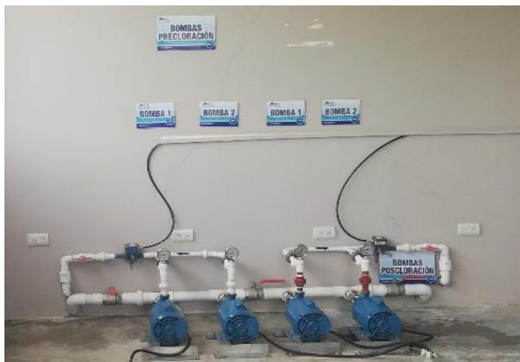
*Figura 15:* Sistema de bombas para el proceso de pre y poscloración.
