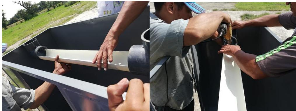
*Figura 28. Corte y montaje de tubería de PVC en la estructura de los prototipos 1 y 2.
