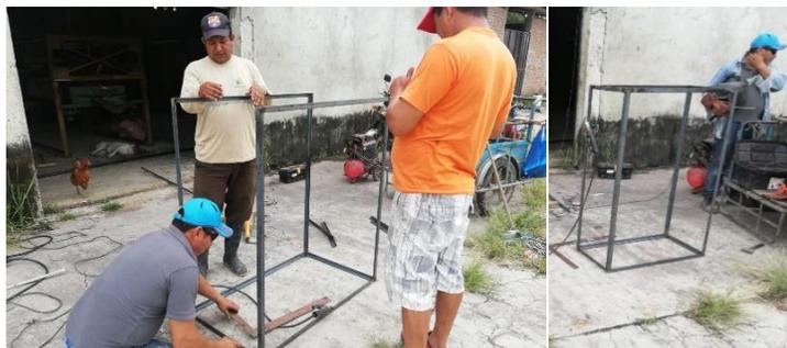
*Figura 21: Soldadura de la estructura del prototipo 2.
