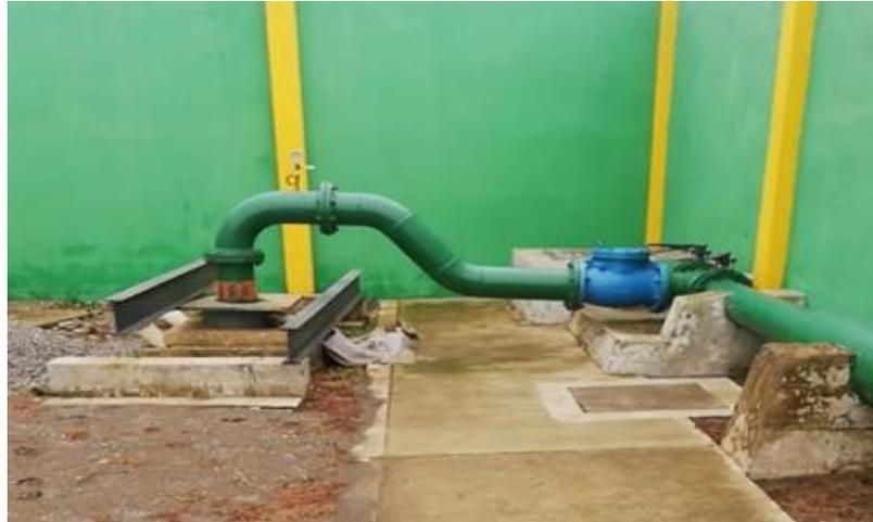
*Figura 13:* Sistema de conducción de agua cruda.
