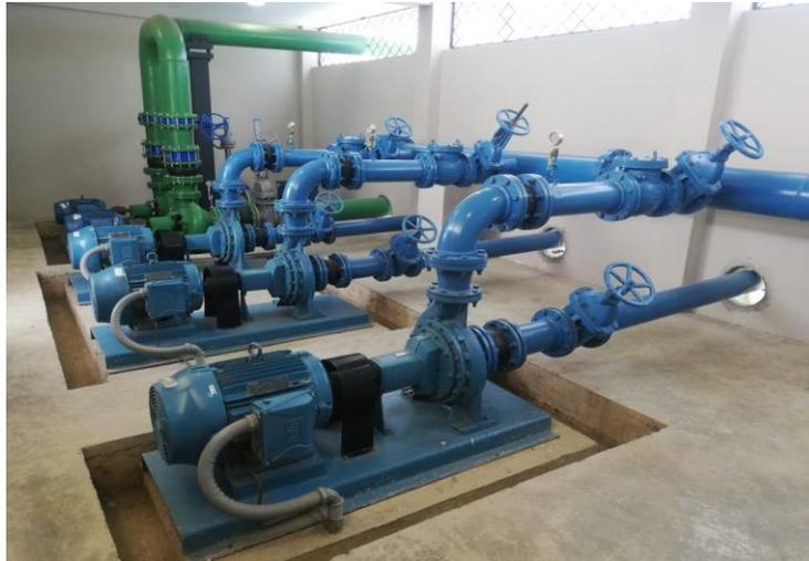
*Figura 17:* Sistema de bombas del sistema booster.
