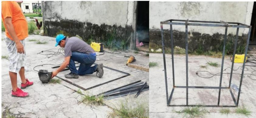
*Figura 20: Soldadura de la estructura del prototipo 1.
