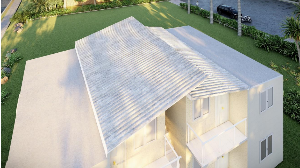
Figura 67: Render perspectiva 3 Visualización en perspectiva de la cubierta a base de PET, papel y vidrio reciclado instalada en la vivienda de interés social.
