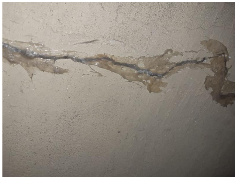
Figura 46. Sellante propuesto en estado desapacible.
