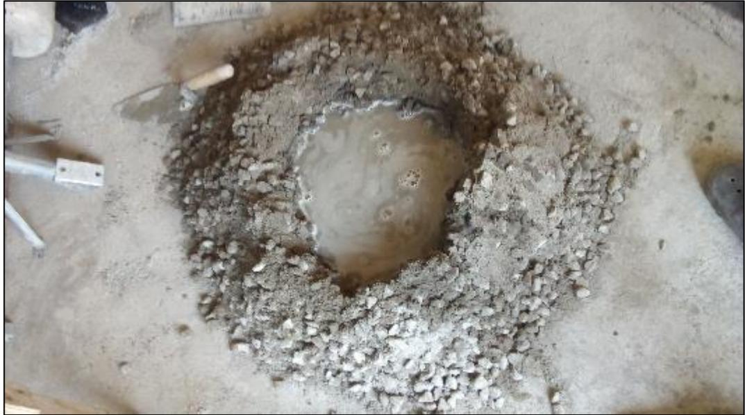
Figura 19 Incorporación de agua a la mezcla seca
