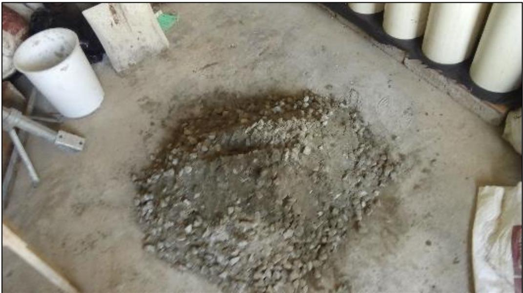
Figura 18 Mezclado en seco
