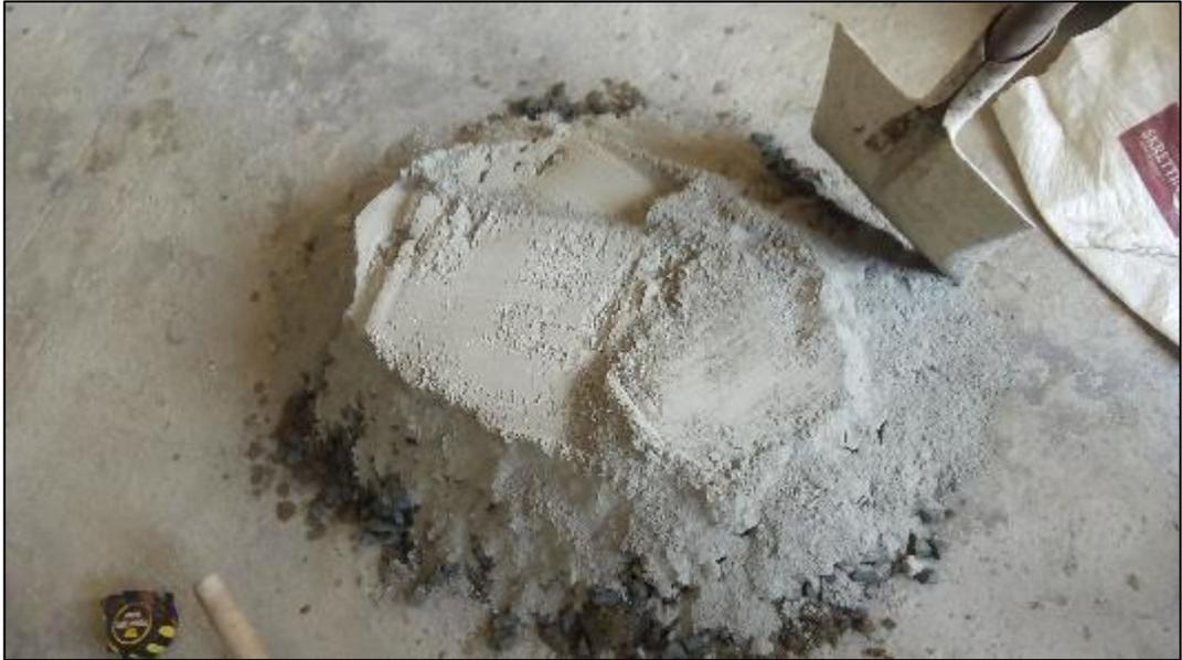
Figura 17 Aplicación de cemento para elaborar hormigón tradicional
