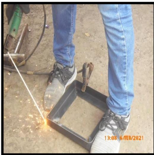
5. Se puntea y suelda con soldadora eléctrica los cortes realizados.
