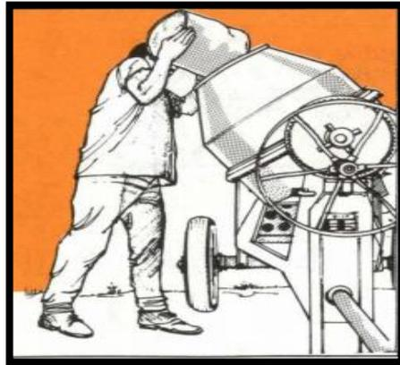
**Figura 13.** Proceso de mezcla con maquina
