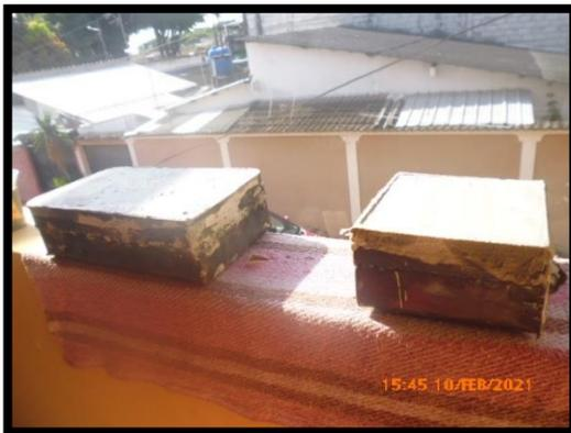
9.- Se deja secar el adoquín de 24 a 48 horas para luego ser desmoldado.
