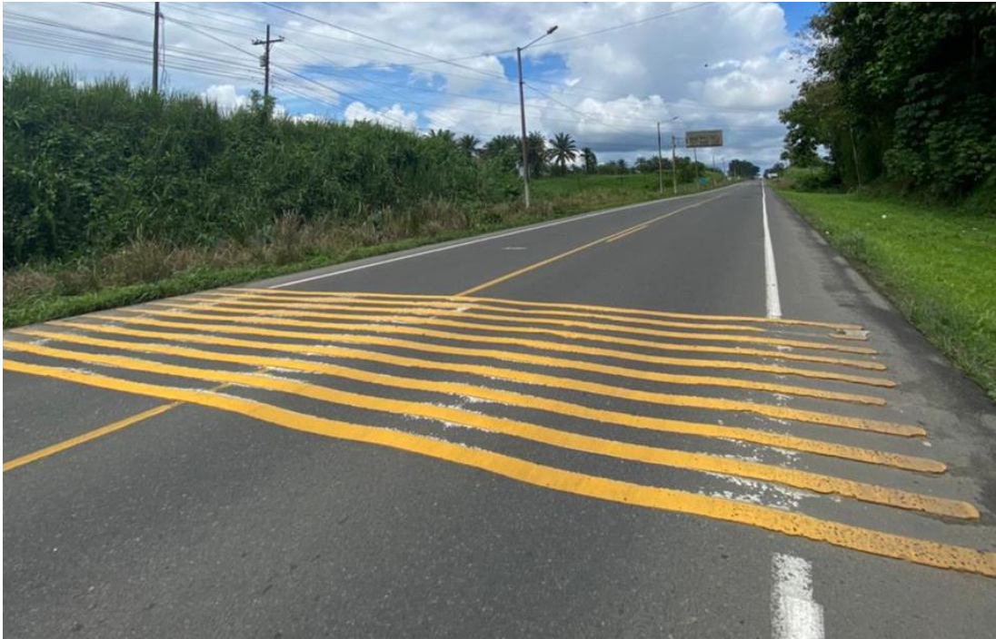
Anexo 10. Señales horizontales en Patricia Pilar.
