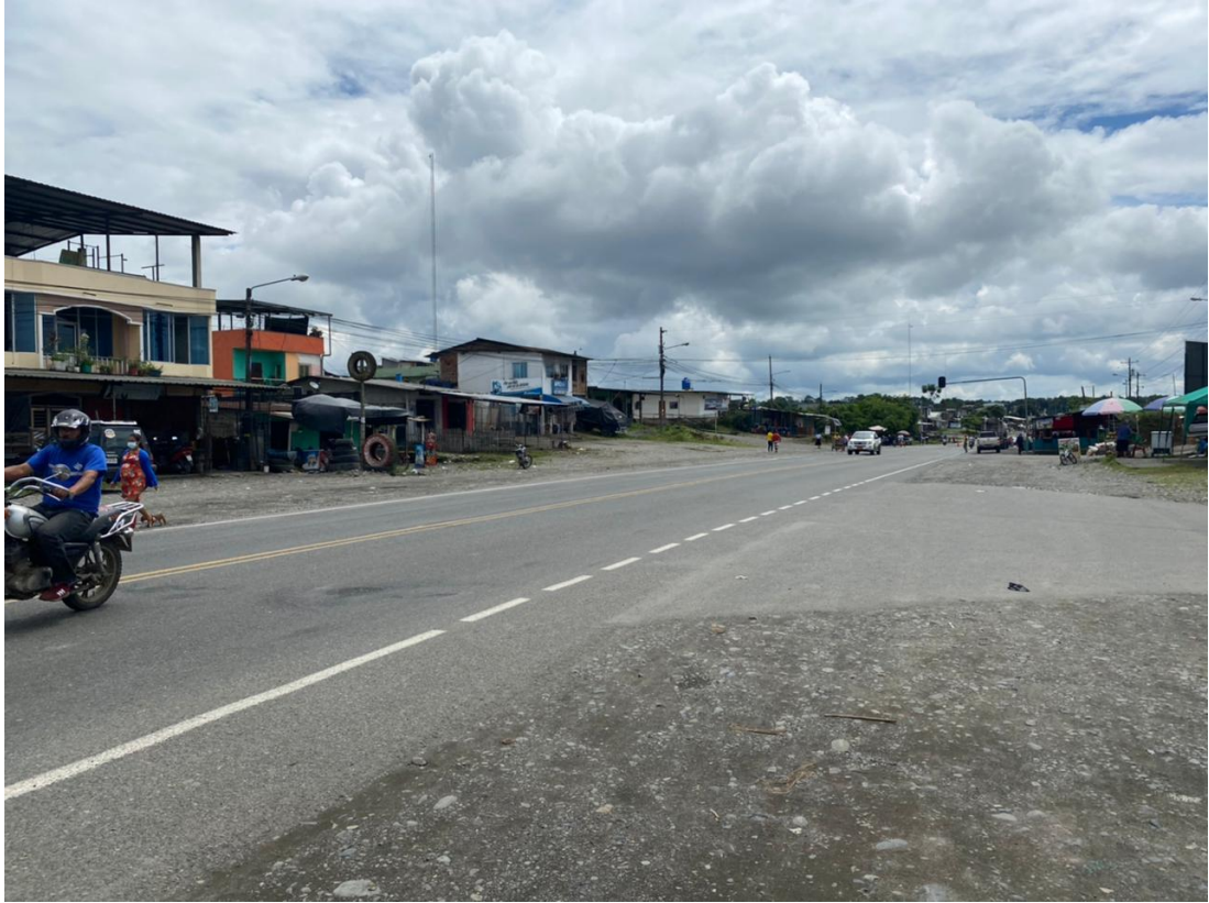
Anexo 3. Carriles estrechos en la Vía Buena Fe – Patricia Pilar.
