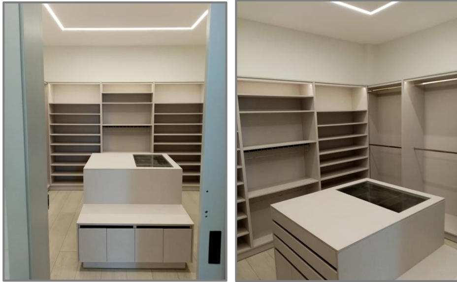
Imagen 60 y 61. Uso de tableros aglomerados Melamínico Fuente: Proyecto Casa Romero Rosillo Elaborado por: Gonzáles, R (2021)
