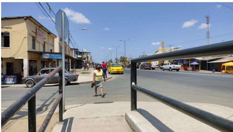
**Figura 19** Cruce peatonal con ausencia de señalización horizontal
