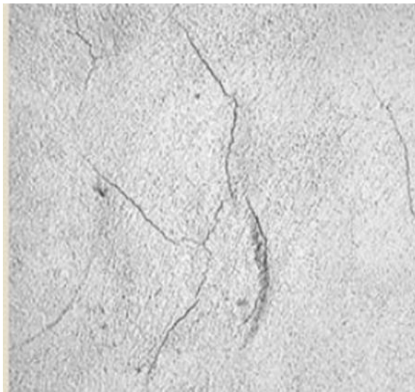
Figura 8: Fisuras superficiales
