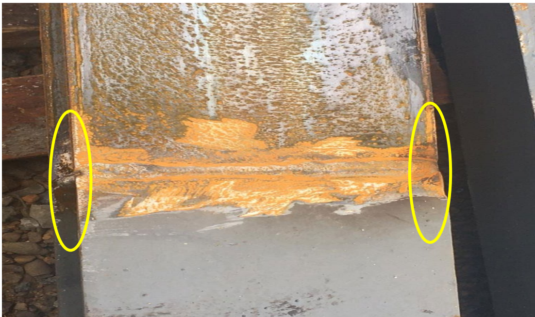
Ilustración 18 construcción de junta
