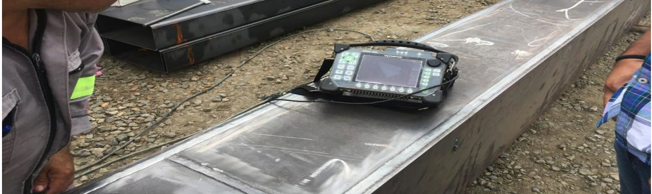
Ilustración 33 Corrección de relleno de cordón de soldadura y ultrasonido
