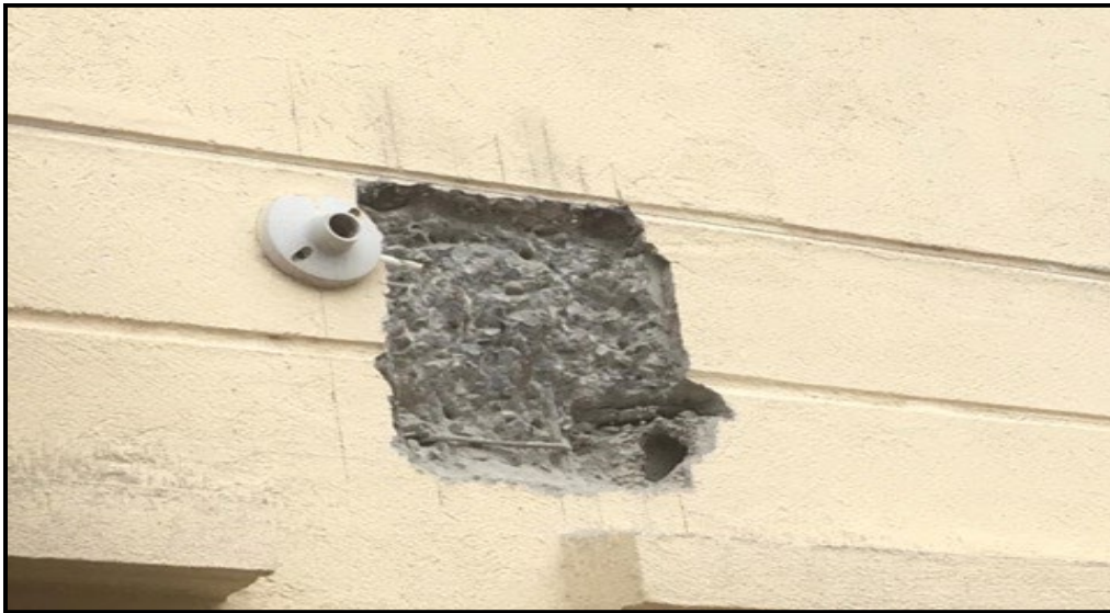
Ilustración 56 Paso de Tubería Eléctrica
