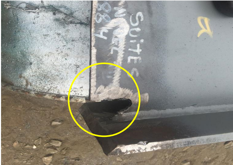
Ilustración 26 Agujero sísmico de acceso a soldadura
