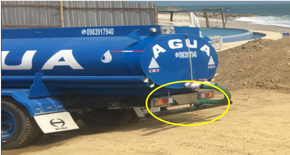
Ilustración 16: uso de acople para hidratación de material.
