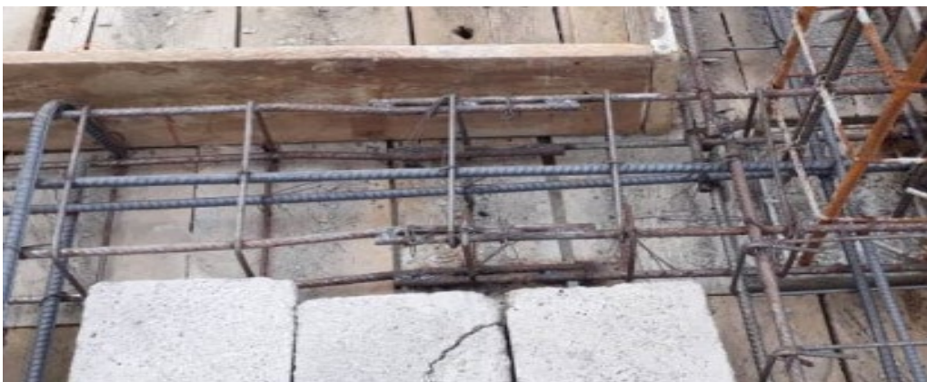
Ilustración 82 Estribos en Vigas rectangulares
