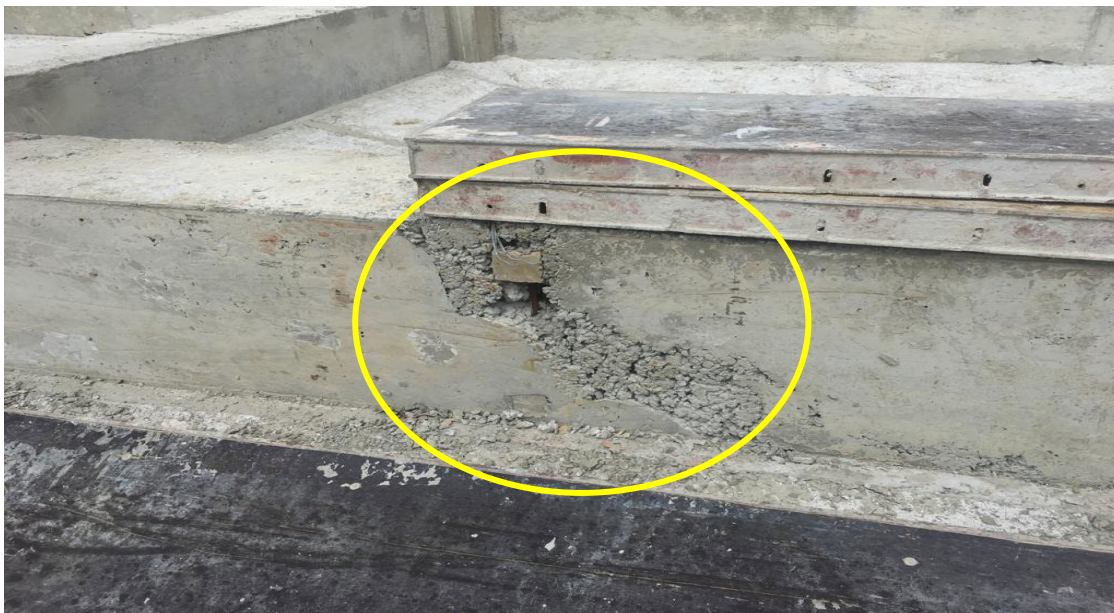
Ilustración 14 Ratonera por segregación
