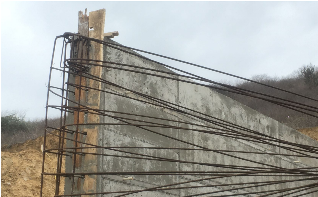
Ilustración 21 Acero de refuerzo doblado
