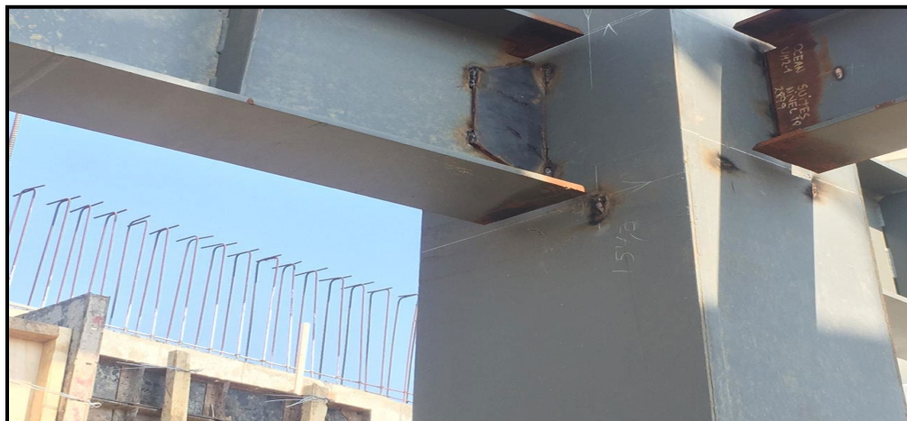
Ilustración 11 Corrección de placa de corte
