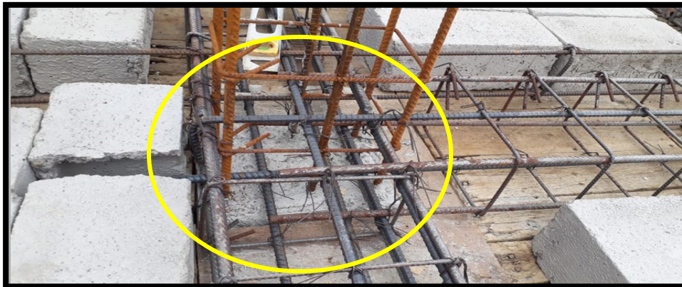
Ilustración 61 Acero de Refuerzo fuera del estribo
