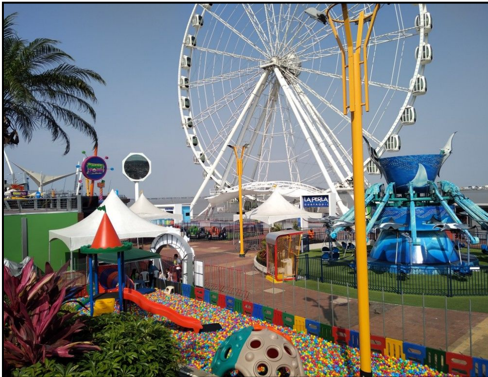
Ilustración 35 Reforzamiento de estructura para montaje de juegos con elementos metálicos y hormigón armado.
