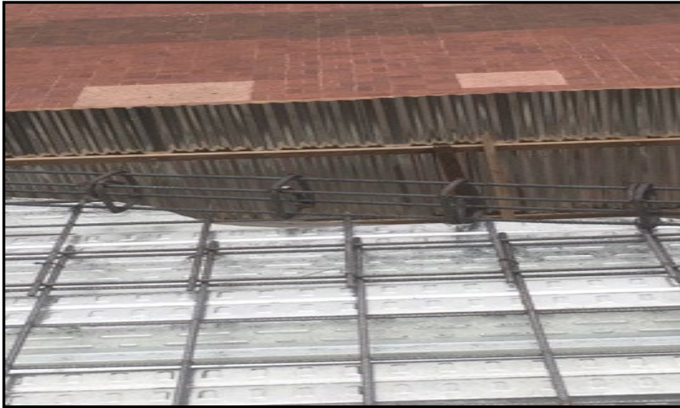
Ilustración 36 Traslape mínimo incorrecto
