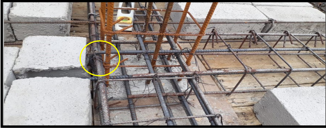
Ilustración 58 Acero de refuerzo longitudinal con gancho
