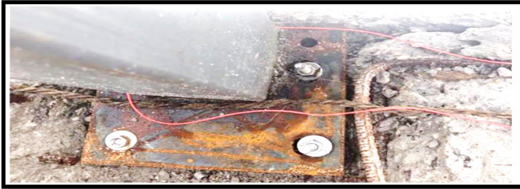
Ilustración 51 Agujero en placa base hechos con oxicorte
