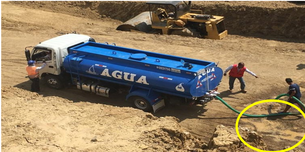
Ilustración 15 Tanquero sin uso de acople
