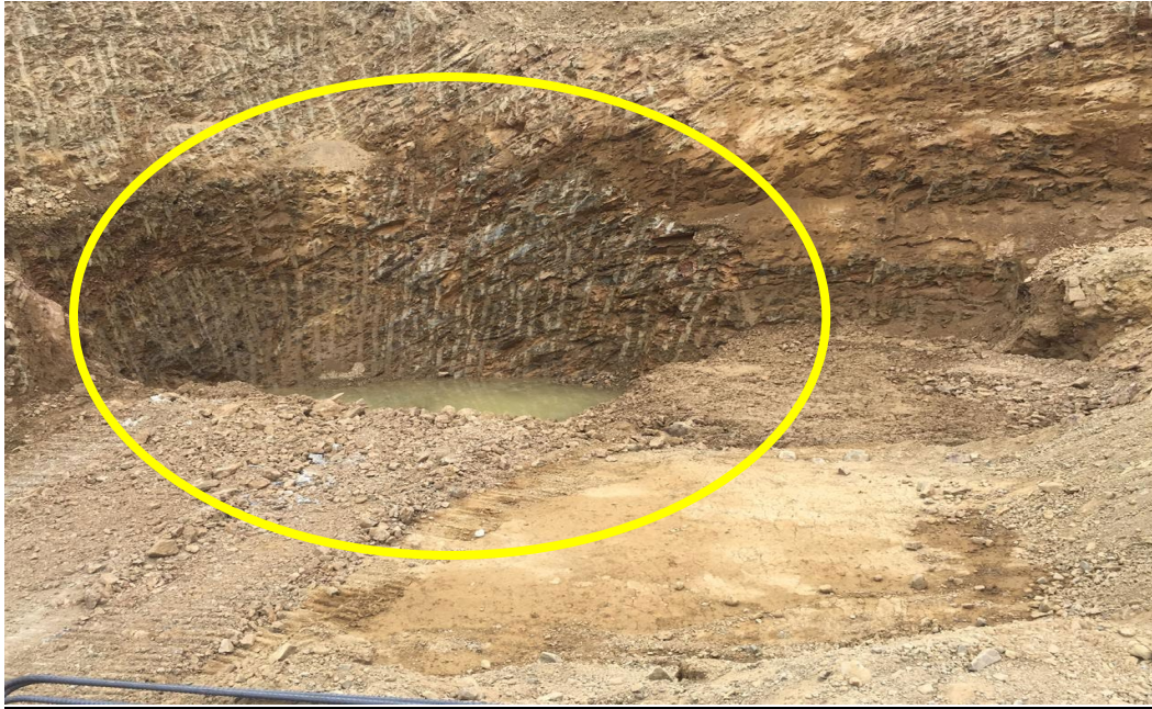
Ilustración 17: Búsqueda del nivel freático
