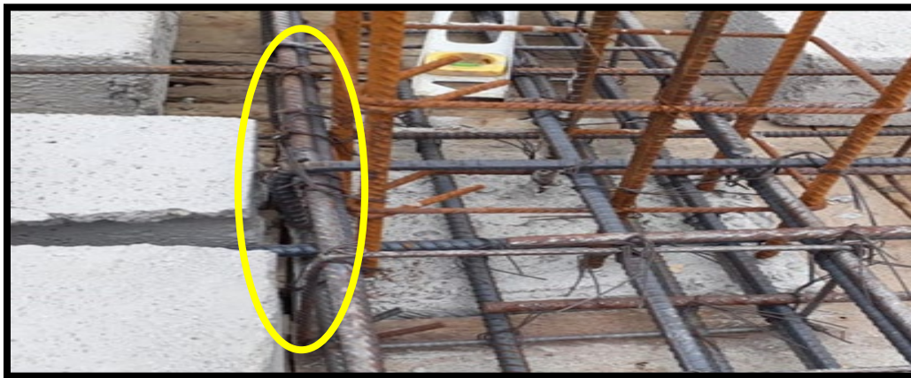
Ilustración 59 Armado de acero de refuerzo
