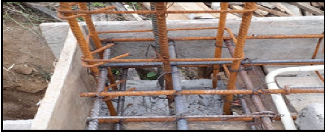
Ilustración 66 Elaboración de la armadura de acero
