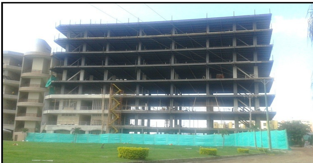
Ilustración 34 Jardines de la esperanza edificio de bóvedas bloque 8 y 9 para Bóvedas
