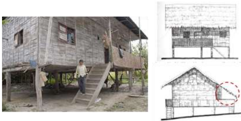
Figura 3 Chozas con técnica de construcción con madera y caña guadúa
