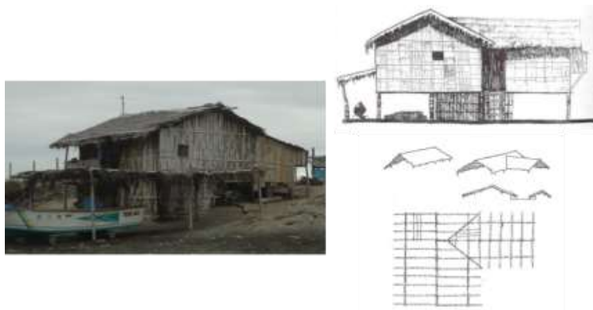
Figura 4 Chozas con técnica de construcción con madera y hojas de tagua
