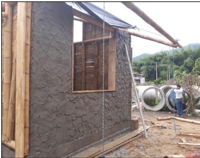
**Figura 13** Encementado de pared de bambú
