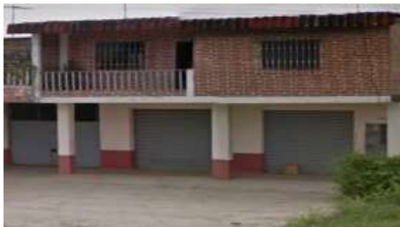
Figura 29. Exteriores del local de la oficina de la operadora
