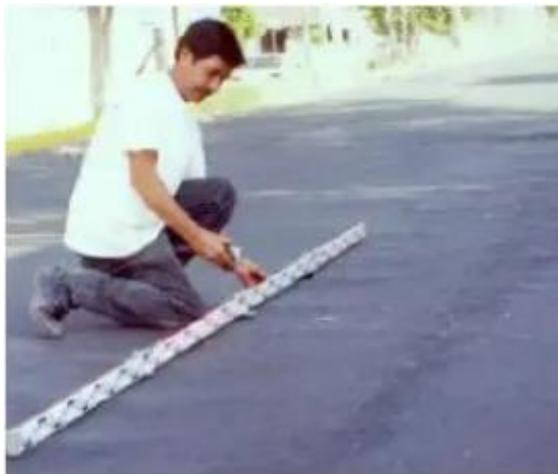
**Figura 12:** Corrugación u ondulación.
