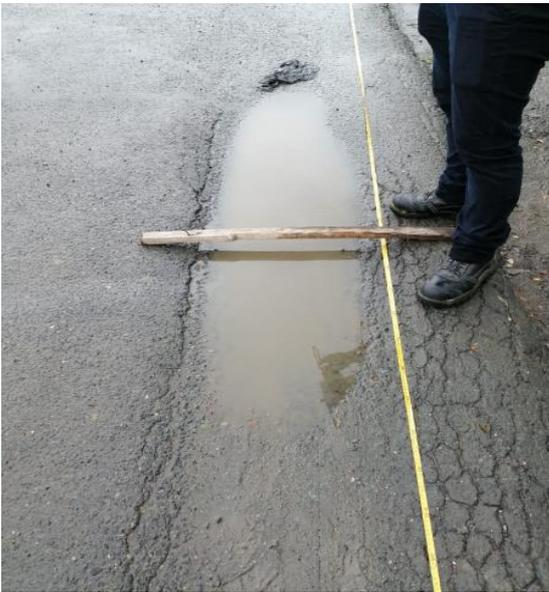
**Figura 40:** Agrietamientos y desprendimientos profundos, movimiento relativo de material.
