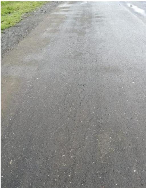
**Figura 38:** Fisuras regulares (ancho menor 2mm) transversales, longitudinales o de esquina que subdividen a las losas en grandes paños
