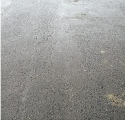
**Figura 37:** Fisuras finas, aisladas ubicadas al azar, que no forman celdas
