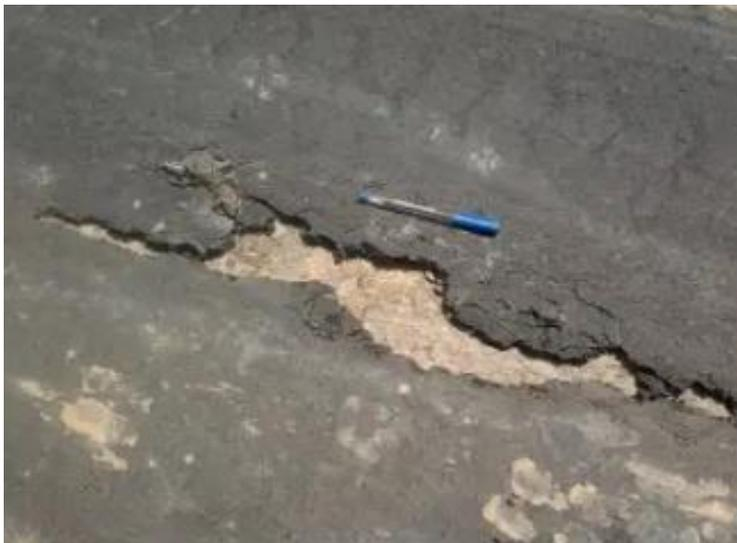
**Figura 3:** Peladura o desprendimiento.
