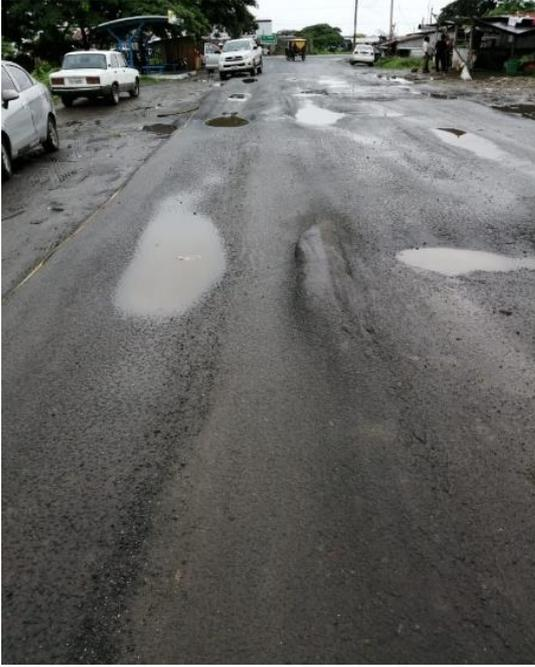
**Figura 39:** Generalización de desprendimientos de material y/o formación de baches, bloques hundidos o asentados
