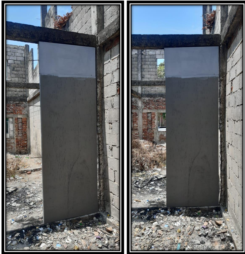
Imagen 65. Instalación de pared con panel portante propuesto. Fuente: Betancourt C. (2020)
