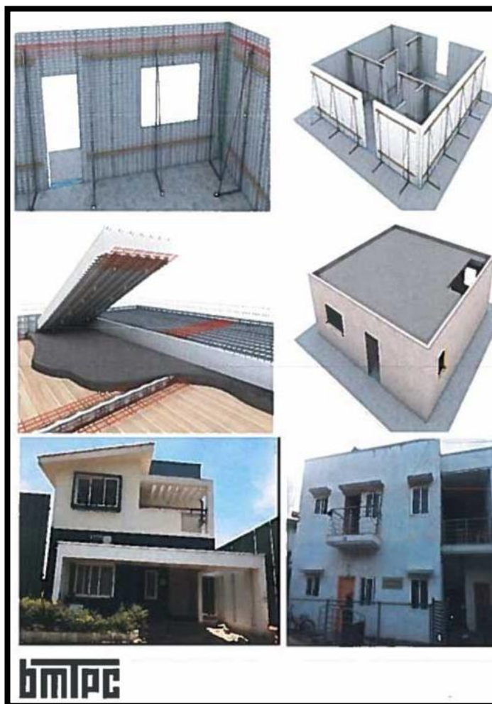
Imagen 1. Paneles portantes en la construcción
