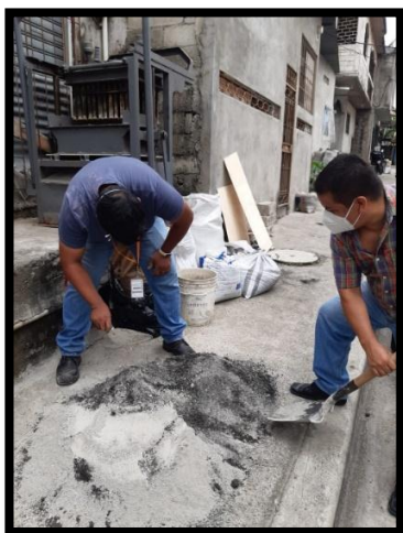
Imagen 55. Colocación de los elementos Elaborado por: Reyes & Villa (2021)
