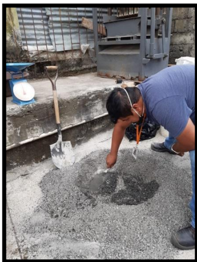
Imagen 52. Colocación de los elementos Elaborado por: Reyes & Villa (2021)
