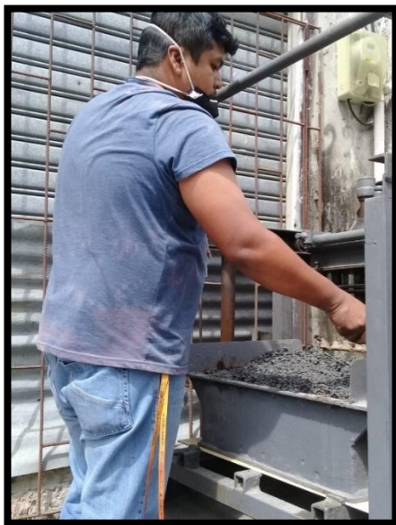
Imagen 54. Vertido de la mezcla en la bloquera Elaborado por: Reyes & Villa (2021)
