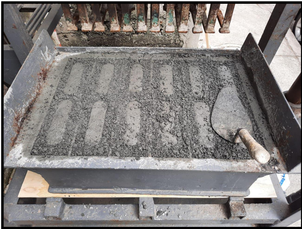
Imagen 58. Rasado de los bloques Elaborado por: Reyes & Villa (2021)
