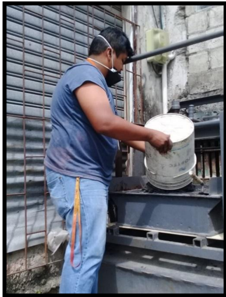
Imagen 50. Vertido de la mezcla en la bloquera Elaborado por: Reyes & Villa (2021)
