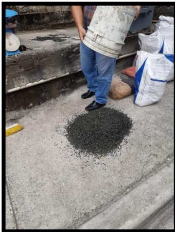
Imagen 44. Colocación de los elementos Elaborado por: Reyes & Villa (2021)
