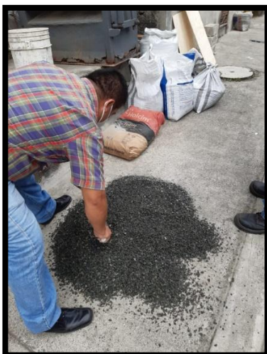
Imagen 45. Colocación de los elementos Elaborado por: Reyes & Villa (2021)
