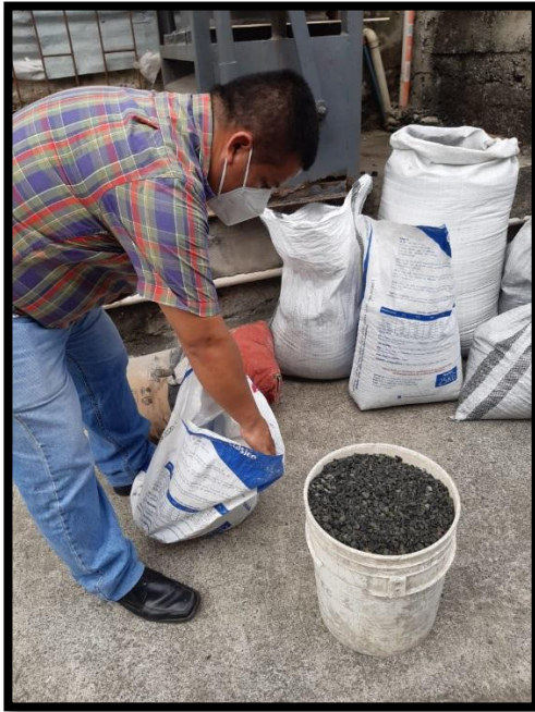
Imagen 47. Colocación de los elementos Elaborado por: Reyes & Villa (2021)
