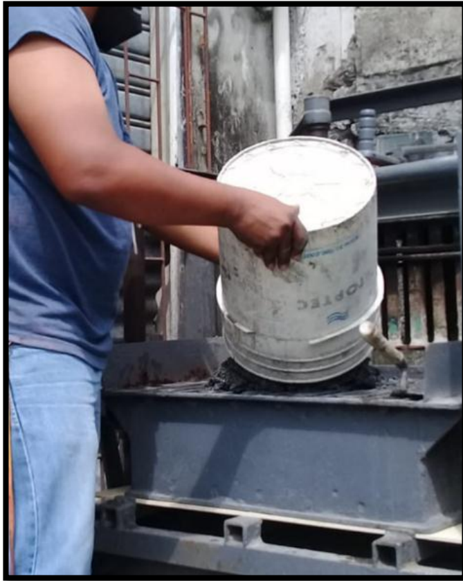
Imagen 61. Vaciado de mezcla a bloquera Elaborado por: Reyes & Villa (2021)
