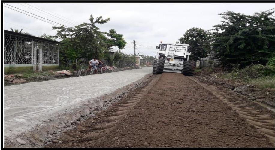
***Figura 1*** Vía secundaria con suelo cemento Holcim base tipo MH
