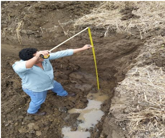
Figura 22. Excavación Elaborado por: Lombeida, X. (2020)
