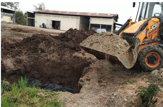
Figura 24. Relleno con material de mejoramiento Elaborado por: Lombeida, X. (2020)
