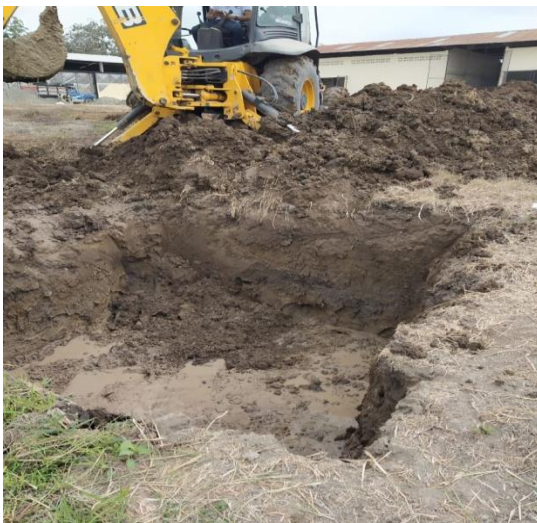
Figura 11. Excavación Elaborado por: Lombeida, X. (2020)
