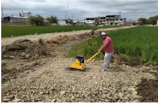
Figura 28. Compactación Elaborado por: Lombeida, X. (2020)
