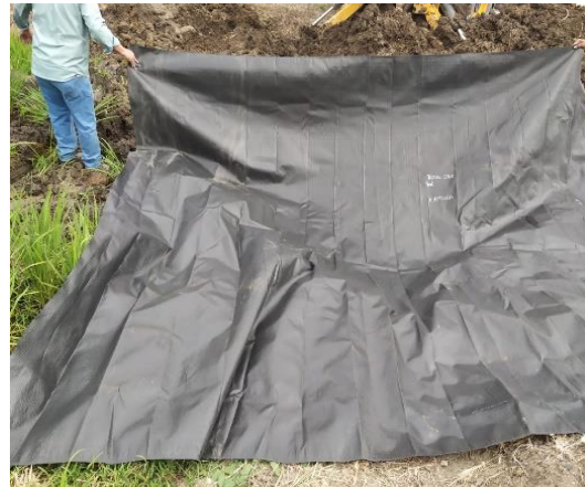
Figura 23. Preparación del Geotextil Elaborado por: Lombeida, X. (2020)
