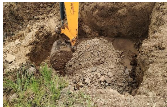
Figura 25. Relleno sin geotextil Elaborado por: Lombeida, X. (2020)
