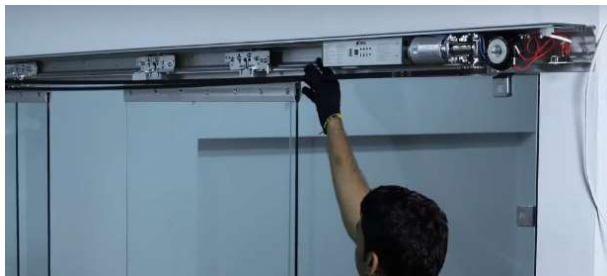
Figura 68. Motor para paneles móviles. Fuente: Obtenido a través de la investigación Elaborado por: Morales, A & Oviedo, I
