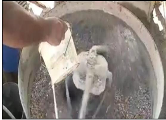
**Figura 60:** Agua vertida en la mezcladora.
