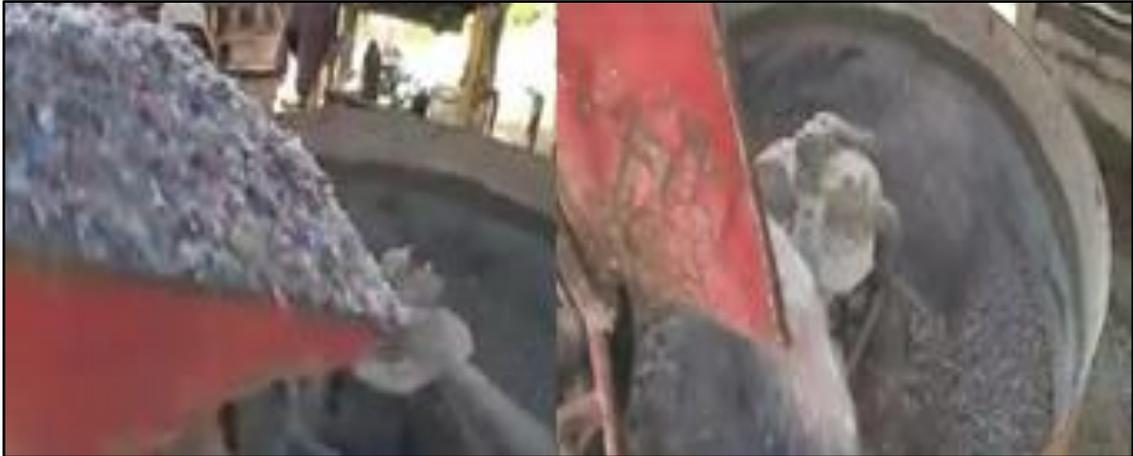
**Figura 55:** Plástico PET – PEAD vertido en la mezcladora.
