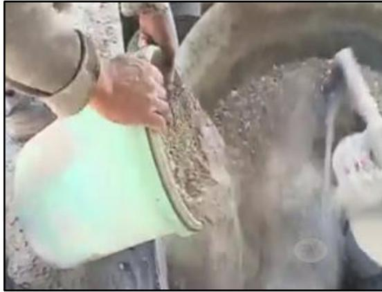
**Figura 57:** Chascu vertido en la mezcladora.
