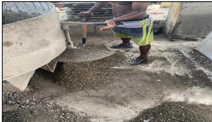
**Figura 62:** Vaciado de la mezcladora.
