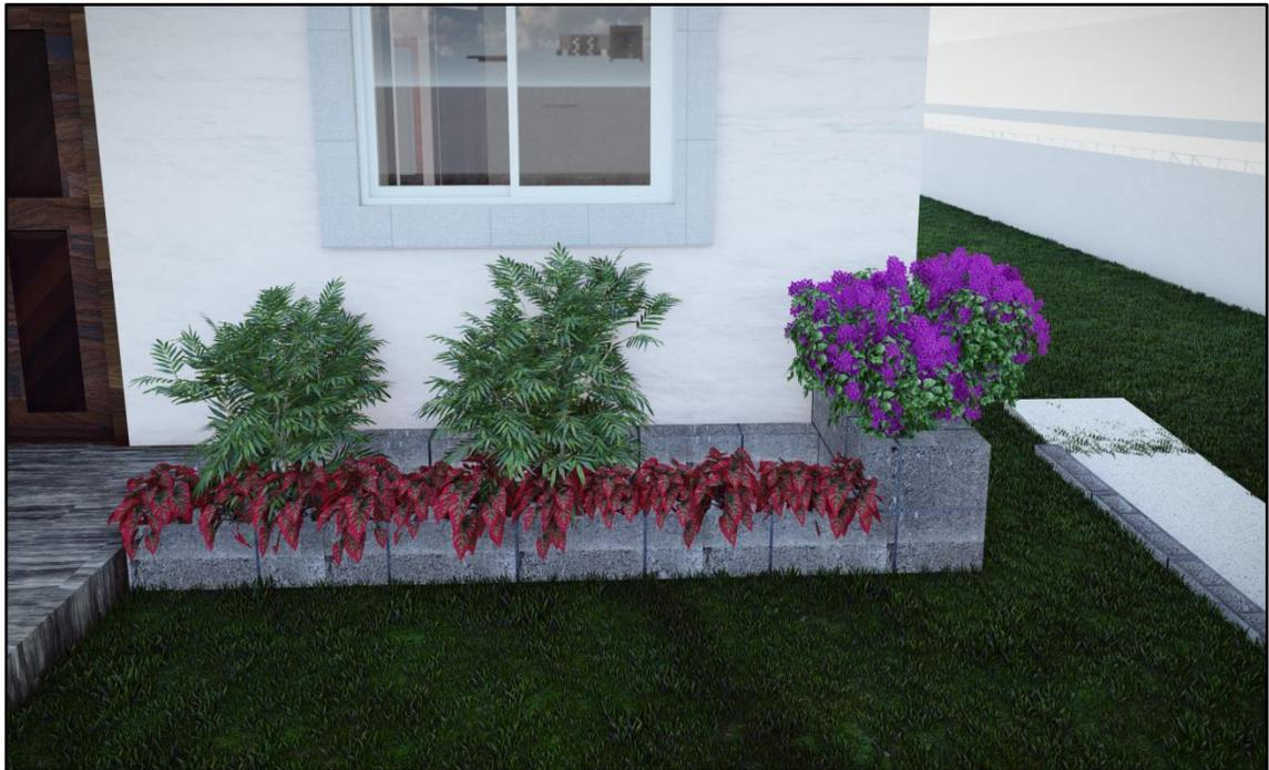
**Figura 94:** *Jardineras construidas con bloques ecológicos (PET – PEAD y Cascarilla de Arroz).*
