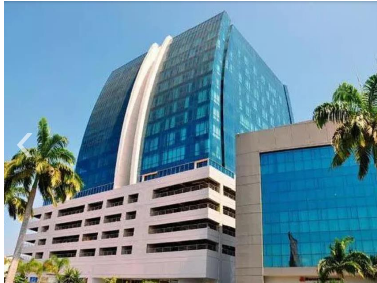
Foto 3. Sucursal norte Edificio Blue Tower Fuente: MEGAPRO Elaborado por: Plúas, A. (2020)
