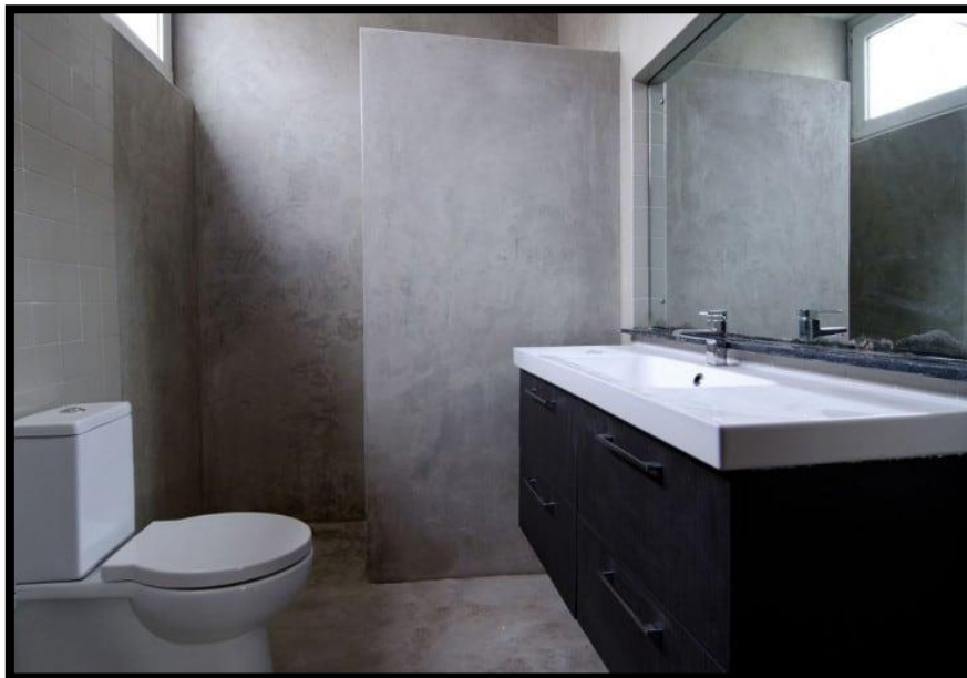
Figura 35. Microcemento pulido. Fuente. Tipos de revestimientos para paredes interiores, ventajas e inconvenientes (2017)
