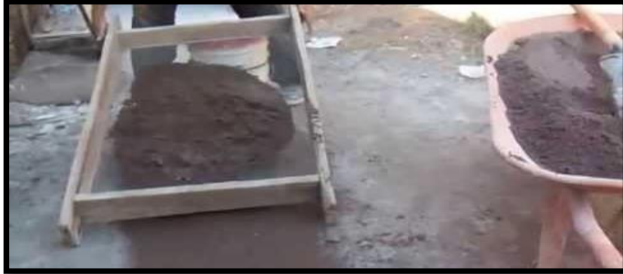
Figura 74. Tamizaje de arena. Elaboración: Alvarado, J. (2019)
