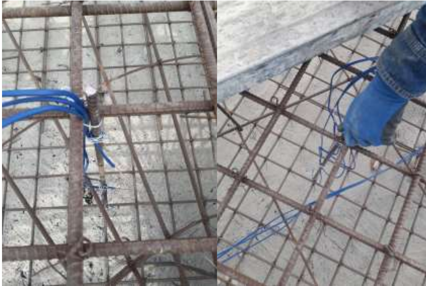
Figura 18 Colocación de las termocuplas Tomada por: (Salvatierra, 2020)
