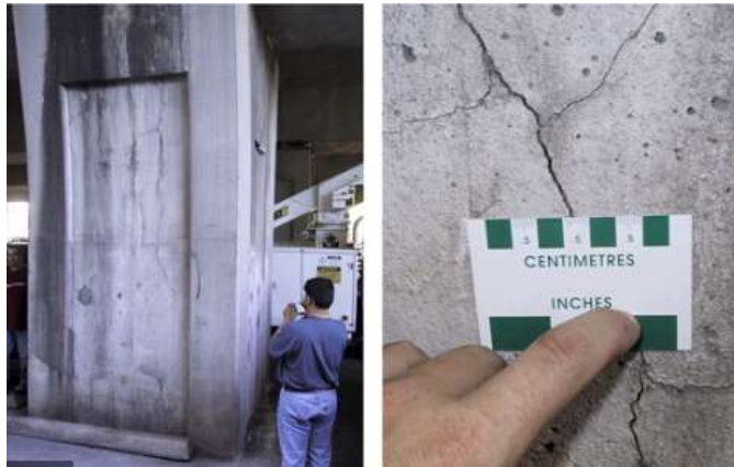
Figura 9 Patrón de expansión interna típica resultado de Formación de Etringita Diferida Fuente: (Aguero, et al., 2019)
