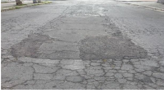
Figura 13 Parches deteriorados.
