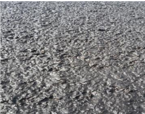
Figura 38 Textura del micro pavimento (antes del curado)
