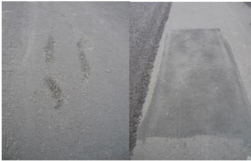
Figura 31 Sellado de fisuras
