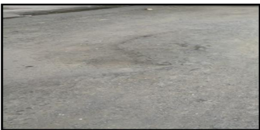
Figura 25 Deformación transversal en la ciudad de Guayaquil
