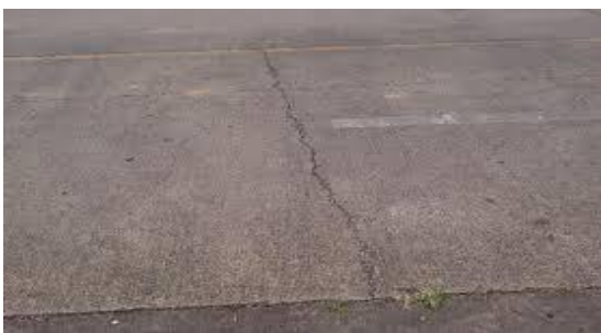
Figura 11 Fisura transversal.
