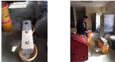
Figura 67: Pegado de pastillas en vigas enlucidas Elaborado por: Martínez & Martillo (2019)
