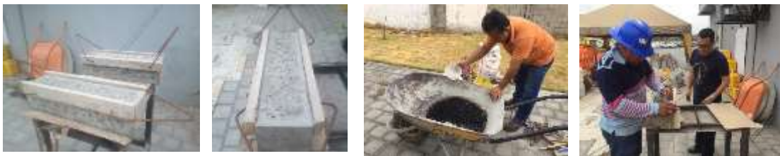
Figura 63: Enlucido de vigas con dosificación (1 cemento:2 arena:1 caucho) y (1 cemento:2 caucho) Elaborado por: Martínez & Martillo (2019)
