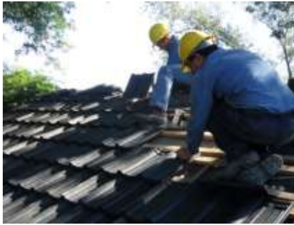
Figura 10: Colocación de tejas obtenidas por el caucho Fuente: Construir tv (2017)
