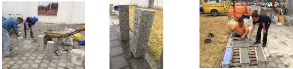
Figura 62: Preparación de superficies de viga Elaborado por: Martínez & Martillo (2019)
