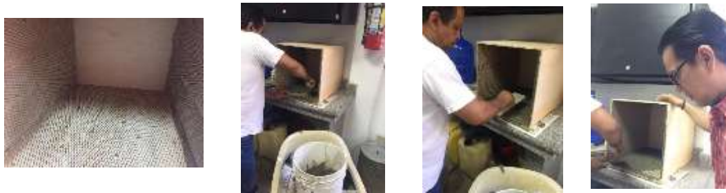
Figura 70: Enlucido interior de cajas Elaborado por: Martínez & Martillo (2019)
