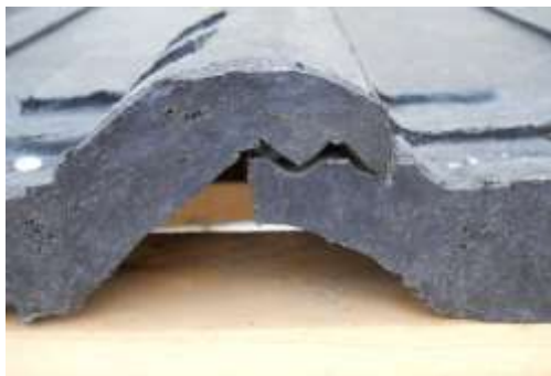
Figura 11: Detalle de unión de tejas con caucho reciclado Fuente: Construir tv (2017)
