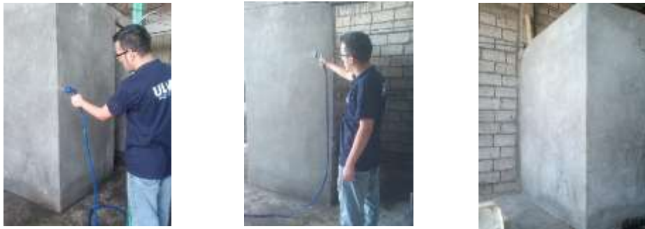
Figura 97: Mortero tradicional con caucho reciclado aplicado en obra Elaborado por: Martínez & Martillo (2019)
