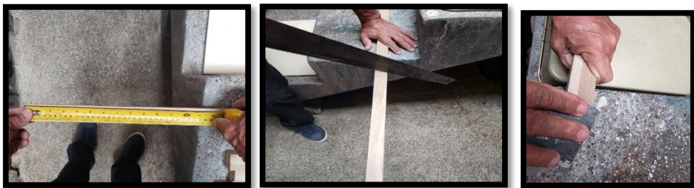
Figura 30. Proceso de medición corte y lijado de las tiras de madera para el molde decorativo Elaborado por: Choez & Torres (2019)
