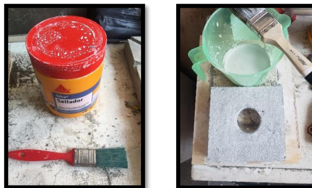
Figura 73: Sellado con impermeabilizante Elaborado por: Choez & Torres (2019)
