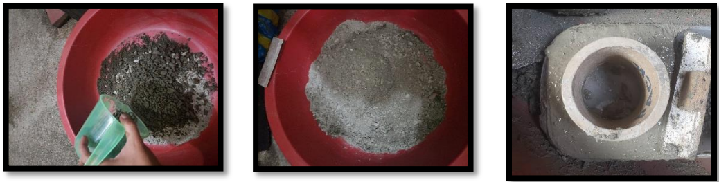
Figura 58: Proceso de mezclado de los materiales para la elaboración del hormigón simple de la muestra #2 Elaborado por: Choez & Torres (2019)
