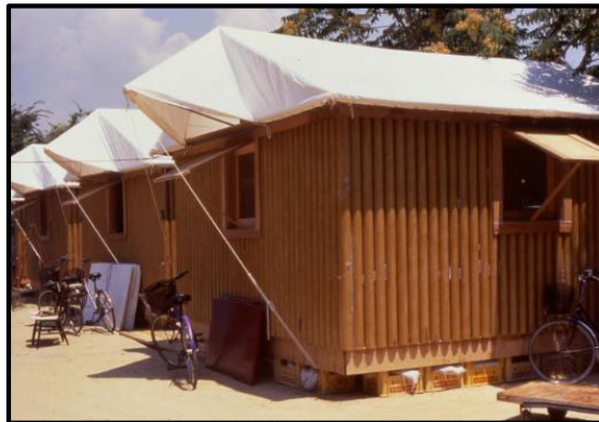
Figura 21: Casa de tubos de cartón Fotografía: Takanohu Sakuma, 2015
