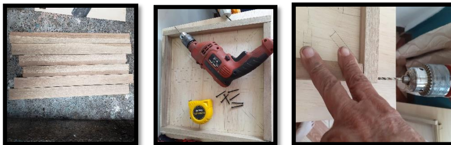
Figura 35: Proceso de corte y colocación de las tiras que conforman las caras externas del molde Elaborado por: Choez & Torres (2019)
