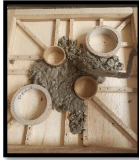
Figura 66: Proceso de vertido del concreto en el molde de madera Elaborado por: Choez & Torres (2019)
