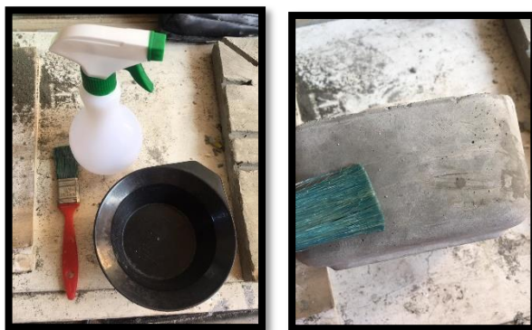
Figura 71: Sellado repelente al agua Elaborado por: Choez & Torres (2019)
