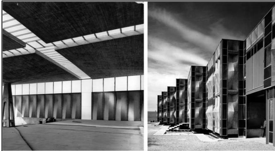
**Figura 8.** Poliéster armado con fibra de vidrio en la obra de Tous y Fargas.
