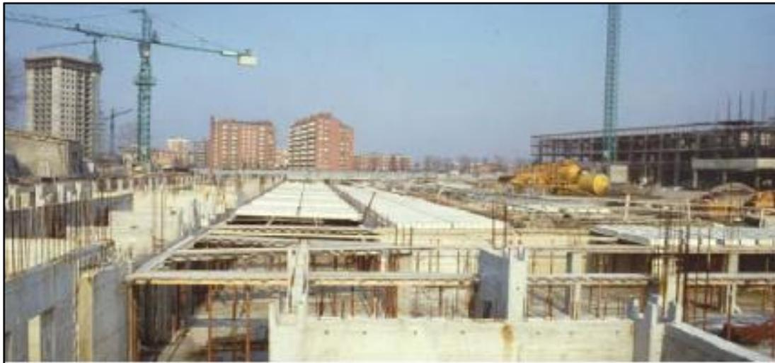
**Figura 14.** Estructura portante de tabiques de hormigón armado vertido en obra con casetones de multilaminado.
