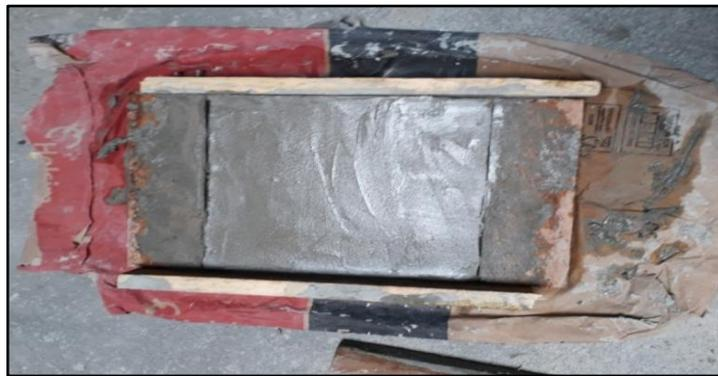
*Figura 49. Colocación del cemento al panel de ambos lados
