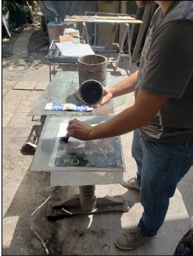
**Figura 43.** Barrido de resina en tetrabrik lijado segunda prueba
