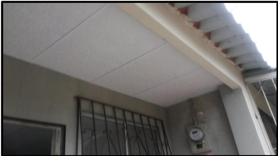
**Figura 123.** Cielo raso instalado en exterior de fachada frontal con el panel propuesto.
