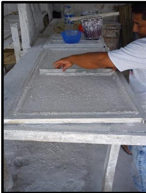
**Figura 82.** Empleo de pulidora de aluminio sobre la mezcla.
