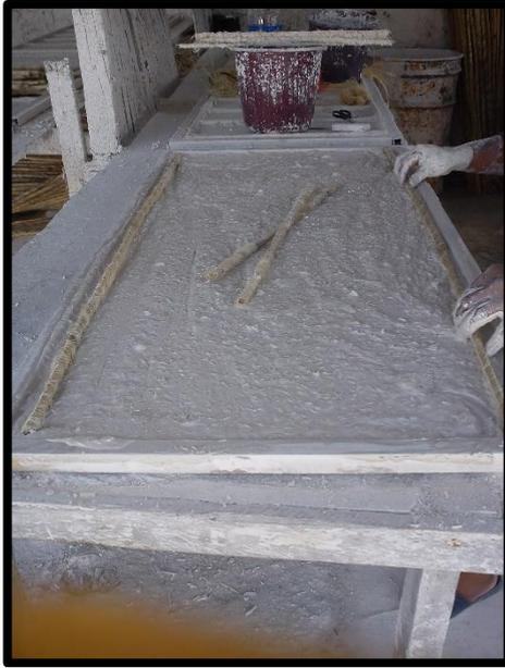
**Figura 83.** Colocación de las cañas.
