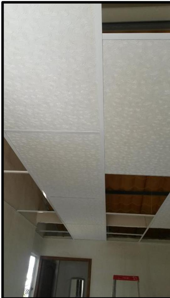
**Figura 118.** Colocación de paneles propuestos.
