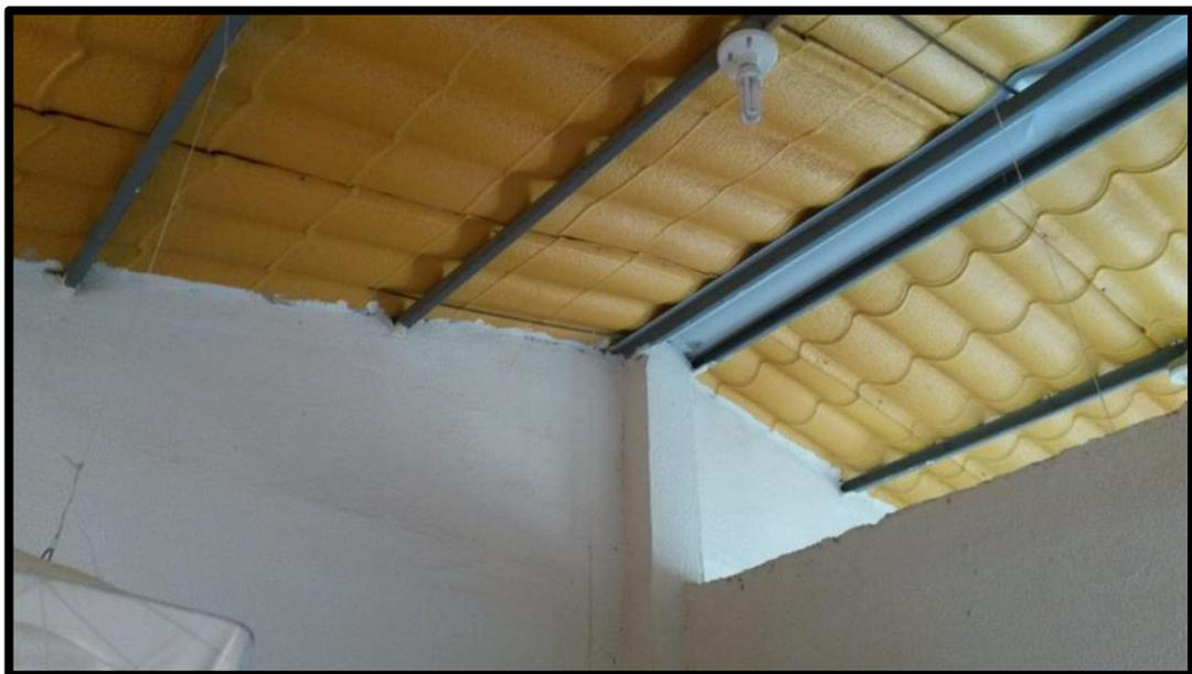
**Figura 116.** Cubierta del área de dormitorio previo a su instalación.
