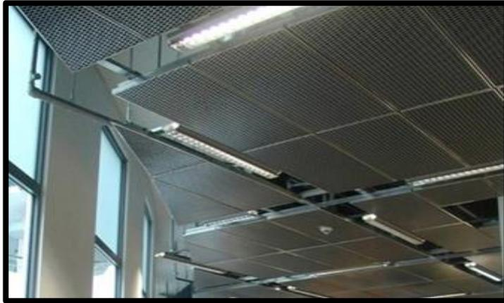
*Figura 40.* Cielo raso metálico.
