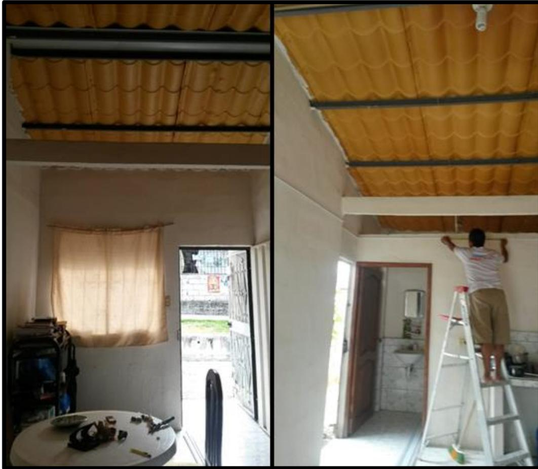
**Figura 113.** Instalación de perfilera de aluminio en vivienda tipo del MIDUVI.
