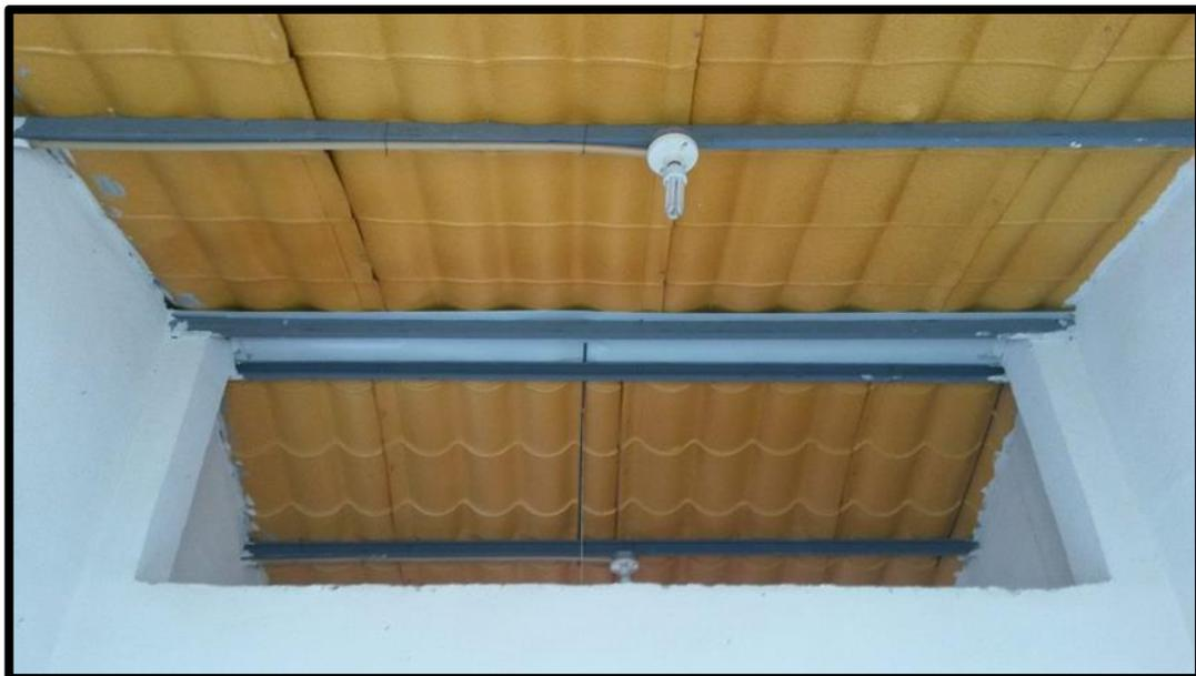
**Figura 114.** Área de cubierta despejada previo a la instalación del cielo raso.
