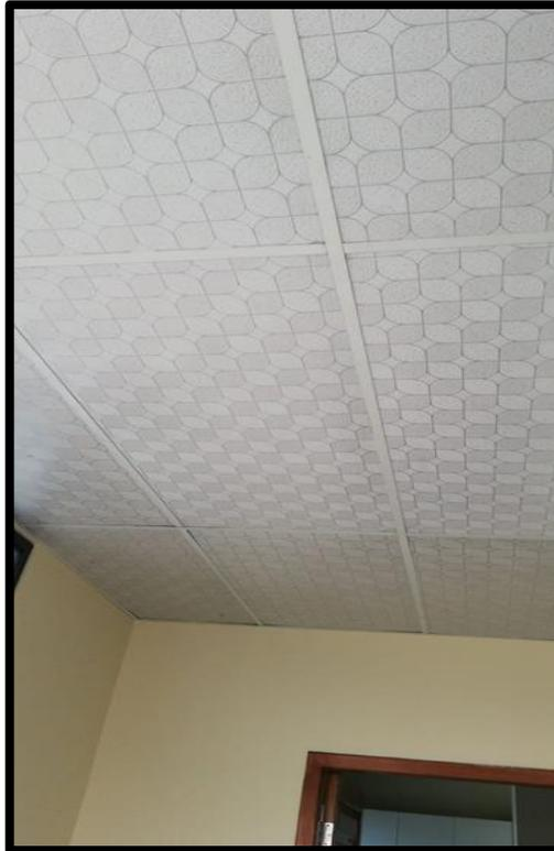
*Figura 92.* Techo falso de yeso instalado en una vivienda.
