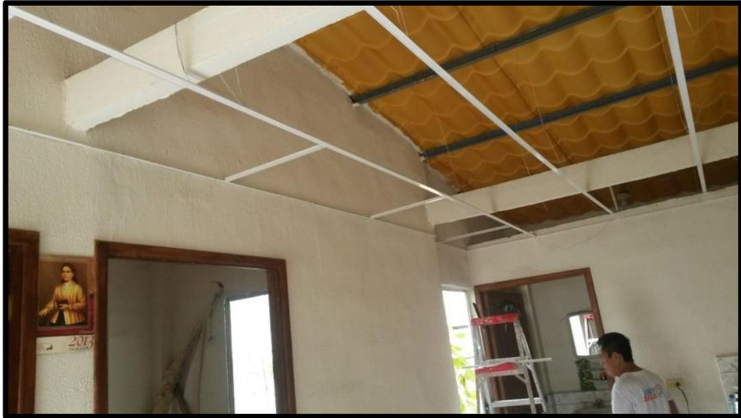
**Figura 117.** Instalación de ángulo perimetral en sala, comedor y cocina.
