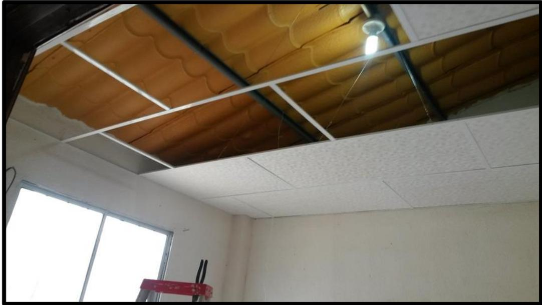
**Figura 120.** Colocación de paneles propuestos sobre las estructuras de aluminio.
