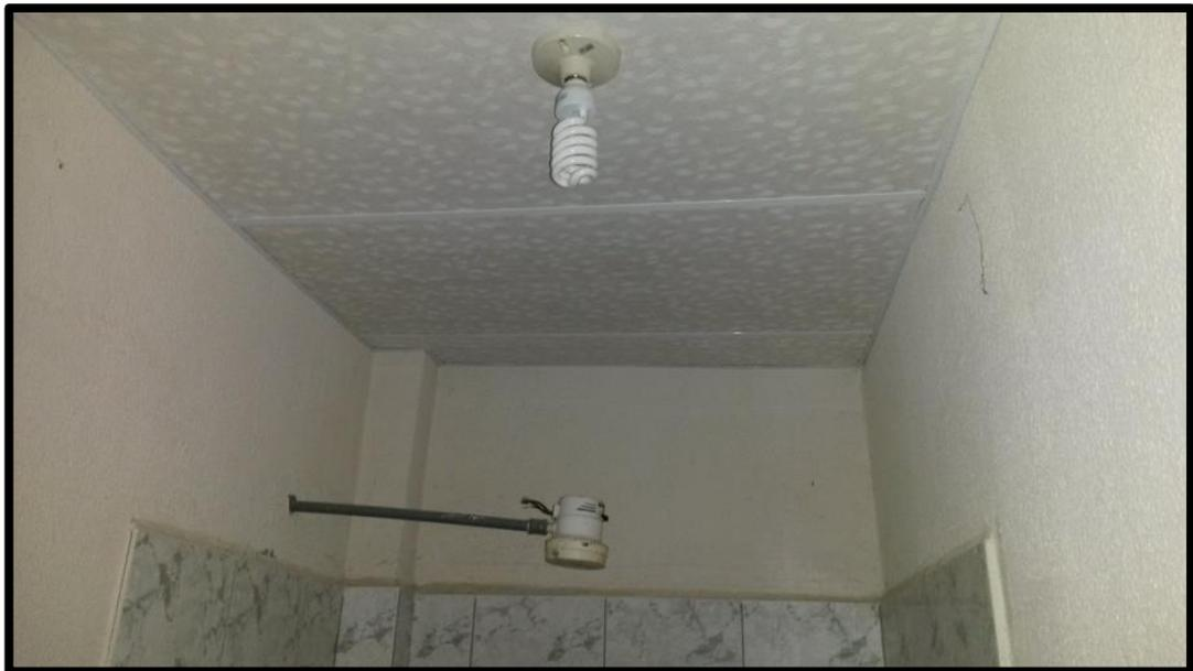
**Figura 121.** Cielo raso instalado en baño con el panel propuesto.
