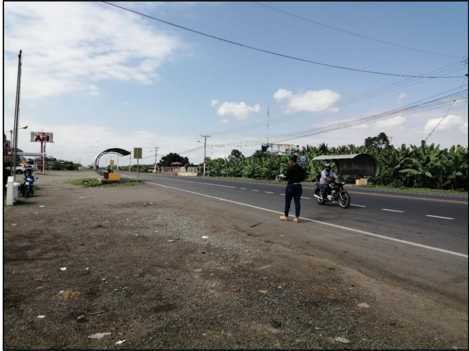
Anexo Fotográfico 3. Inspección de Seguridad Vial.
