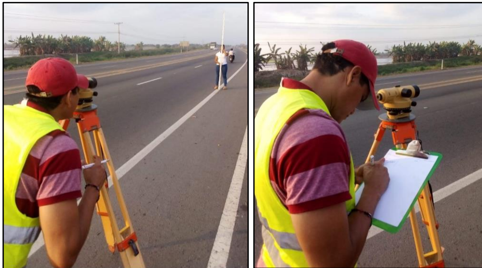
Anexo Fotográfico 2. Medición de peralte y radio en las curvas horizontales.
