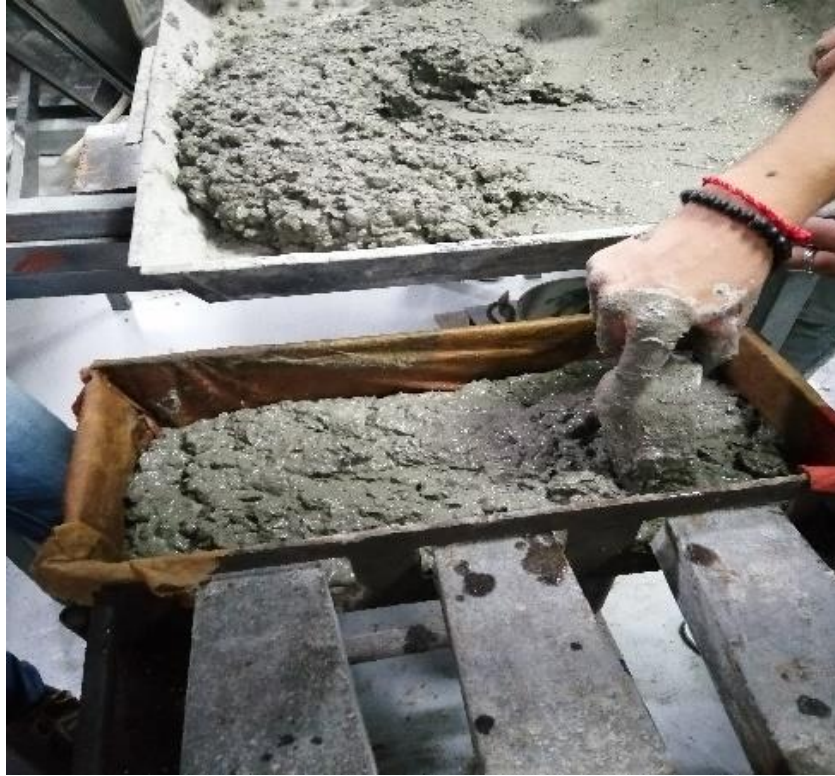
Figura 24 Vertido de hormigón en molde para bloque
