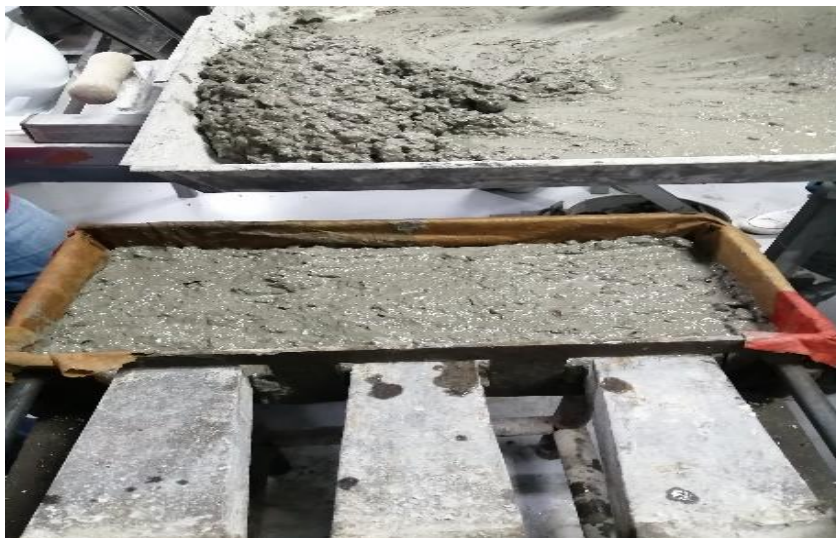
Figura 25 Vertido de hormigón en el molde
