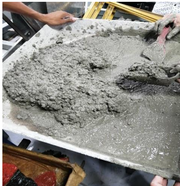
Figura 22. Mezcla de hormigón para eboración de bloques
