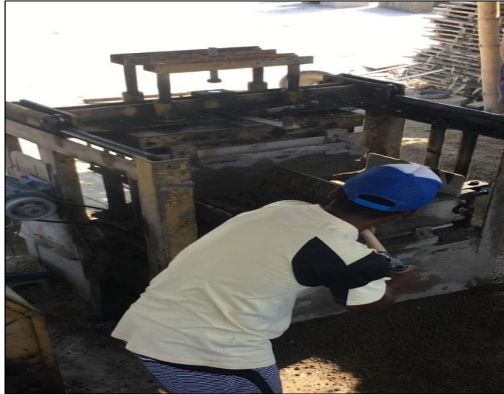
Figura 63: Maquina que compacta el bloque Elaborado por: Castro & Farfán (2019)
