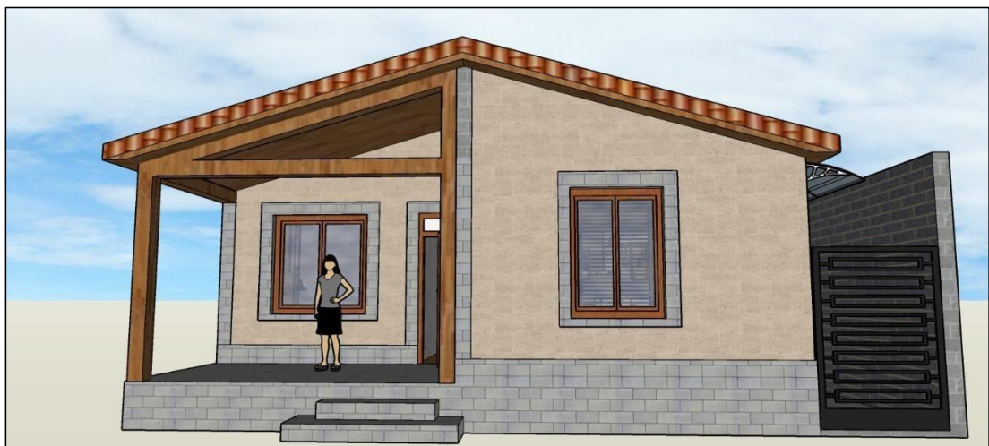
Figura 80: Vista frontal de la vivienda de interés social elaborada con eco-bloques a base de caucho triturado y aserrín.
