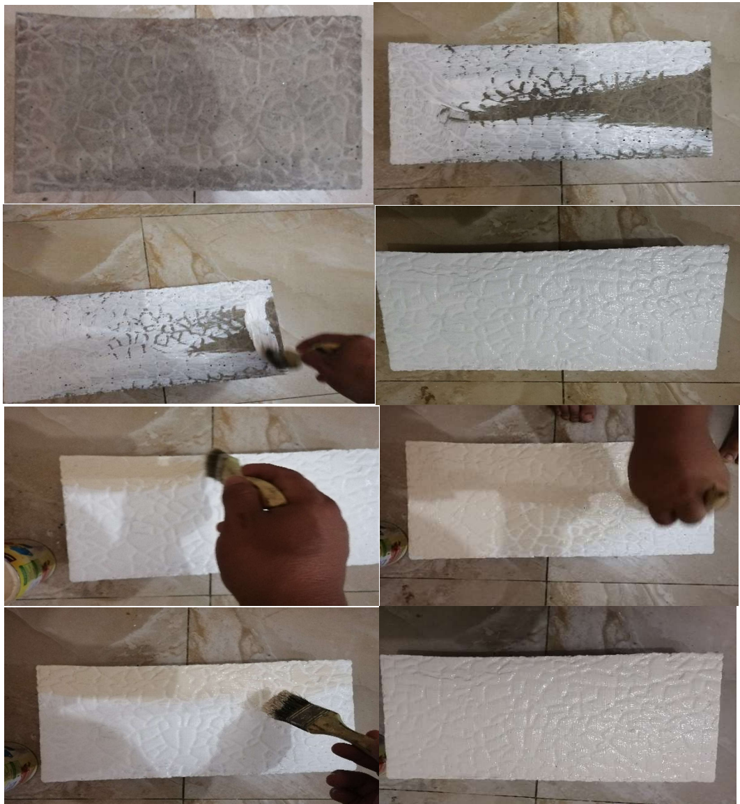
Imagen 78 Aplicación de sellador exterior y pintura elastómera
