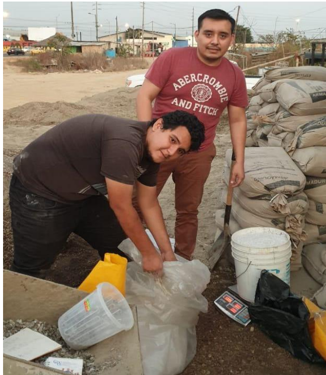
Figura 43 Trabajos en la bloquera Tomada por: Macancela. A & Martínez. A (2019)
