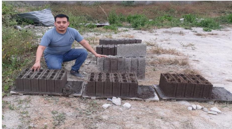
Figura 45 Desmolde en la bloquera Tomada por: Macancela. A & Martínez. A (2019)
