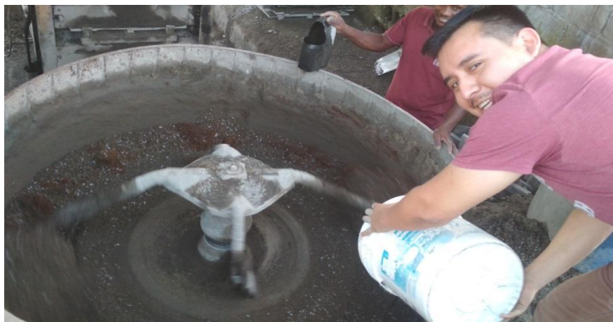
Figura 39 Máquina que da forma a los bloques Tomada por: Macancela. A & Martínez. A
