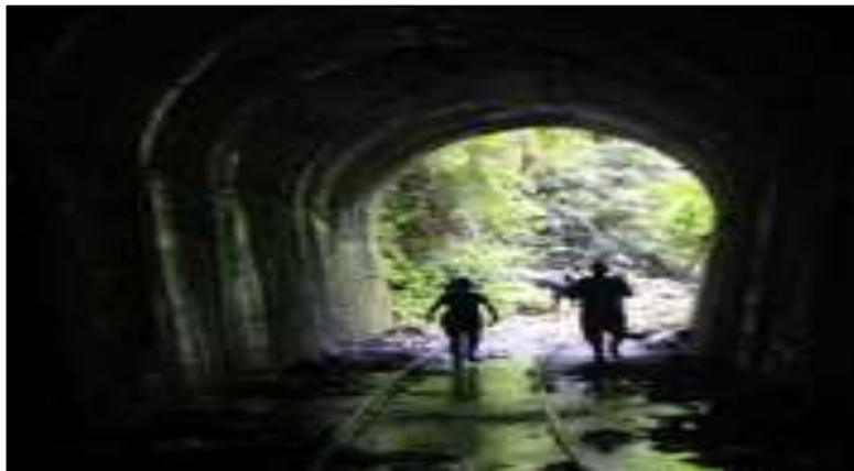
Figura 16. Túnel Fuente: Google (2014)
