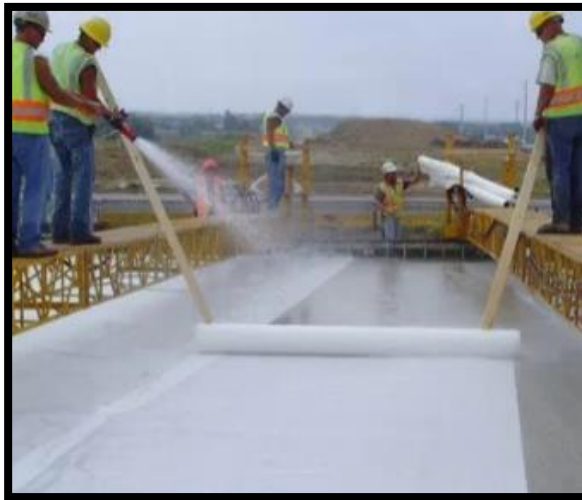
Imagen 25. El agua en la construcción Fuente: Arkiplus (2018)
