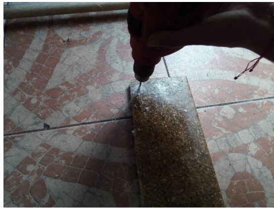
Figura 59. Prueba de perforado.
