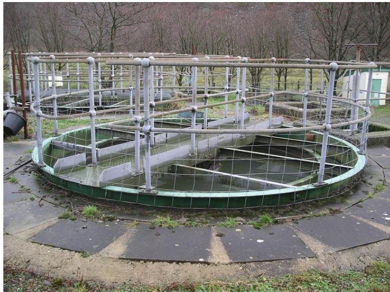
*Figura 3: Tanque de sedimentación primaria
