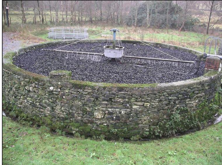
*Figura 4: Filtro oxidante de una planta rural*
