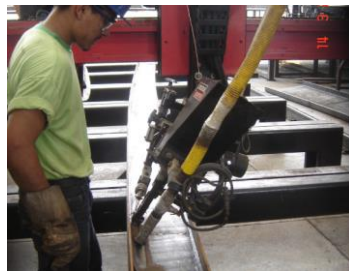
Figura 8 : servicio de soldadura
