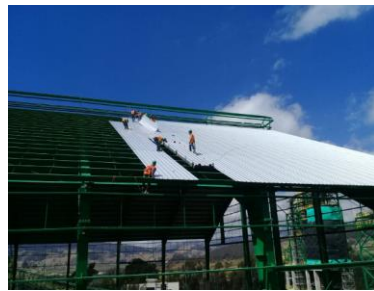
Figura 5 : Instalación y montaje industrial
