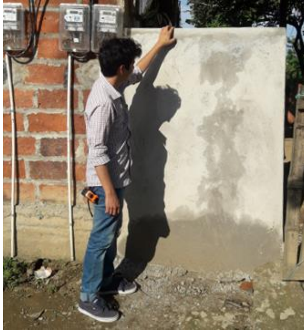
Figura 64 Culminación de construcción de pared Tomado por: Santos, M. (2019).
