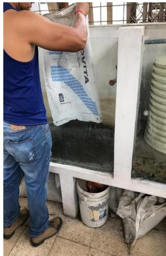
**Ilustración 11.** Colocación de arena gruesa
