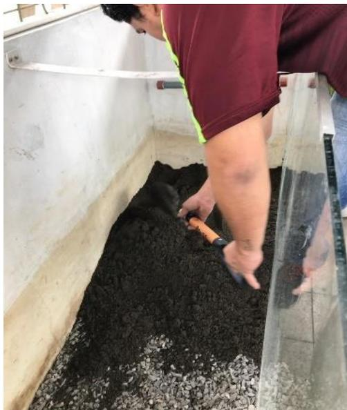
**Ilustración 6.** Colocación de Arena gruesa.
