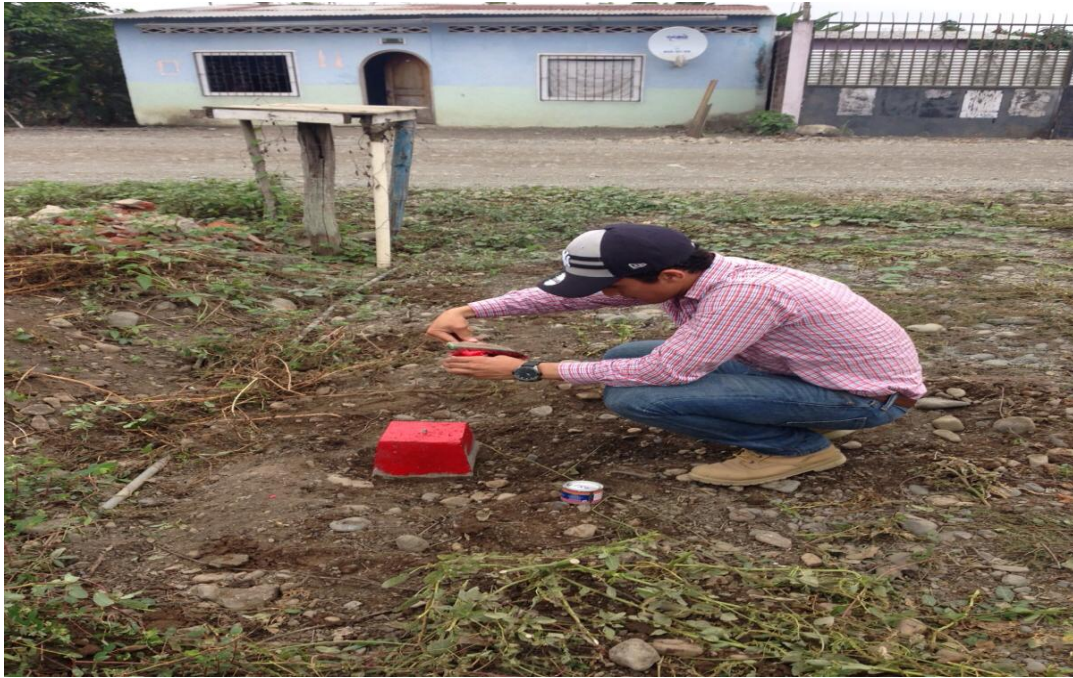
Figura # 8. Colocación de Hitos para Topografía. Fuente: Autores
