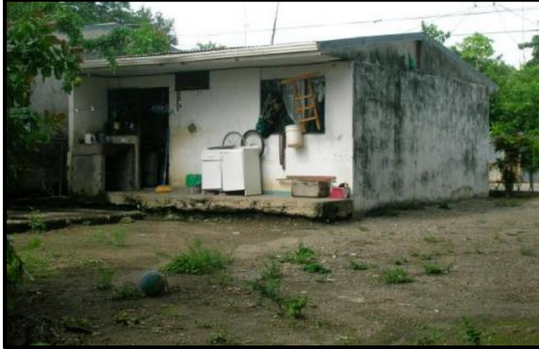
Ilustración 23: Casa Construida con bloques de cáscara de arroz. Fuente: Molina Salas, E. (2015)
