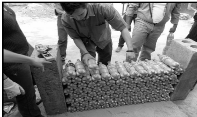
Ilustración 7: Construcción de muros con botellas llenas de escombros. Fuente: , Ruiz & López (2012)
