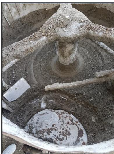
Figura 30. Colocación de los materiales en el tambor para mezclar
