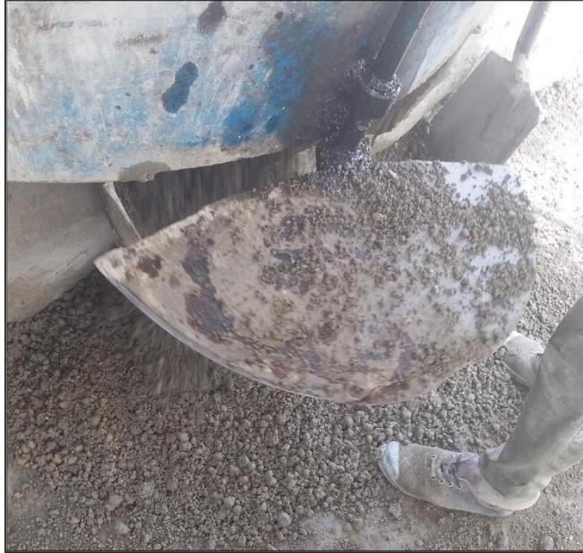
*Figura 33.* Retiro de la mezcla de la máquina de mezclado
